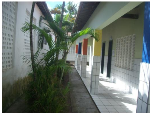
Foto 2 - Área de Circulação entre as Salas.
