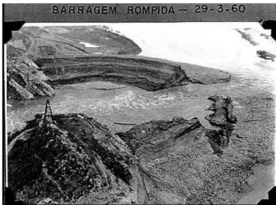
Imagem 12: Visão da barragem rompida
