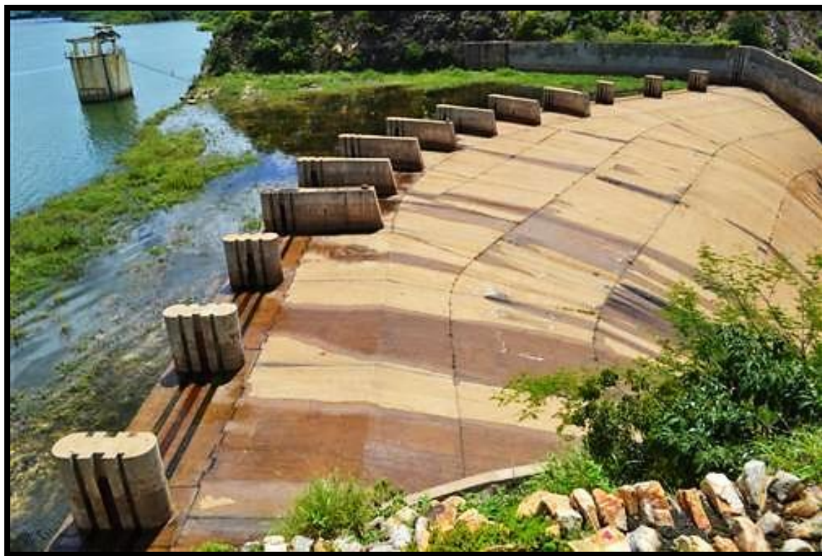
Imagem 15: Vertedouro do Açude Orós. Orós, 2010.
