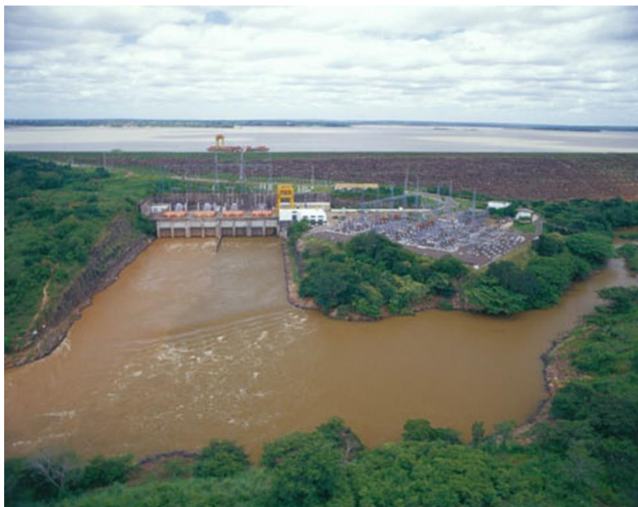
Figura 1 – Usina hidrelétrica de Boa Esperança, médio rio Parnaíba, região Nordeste do Brasil.
