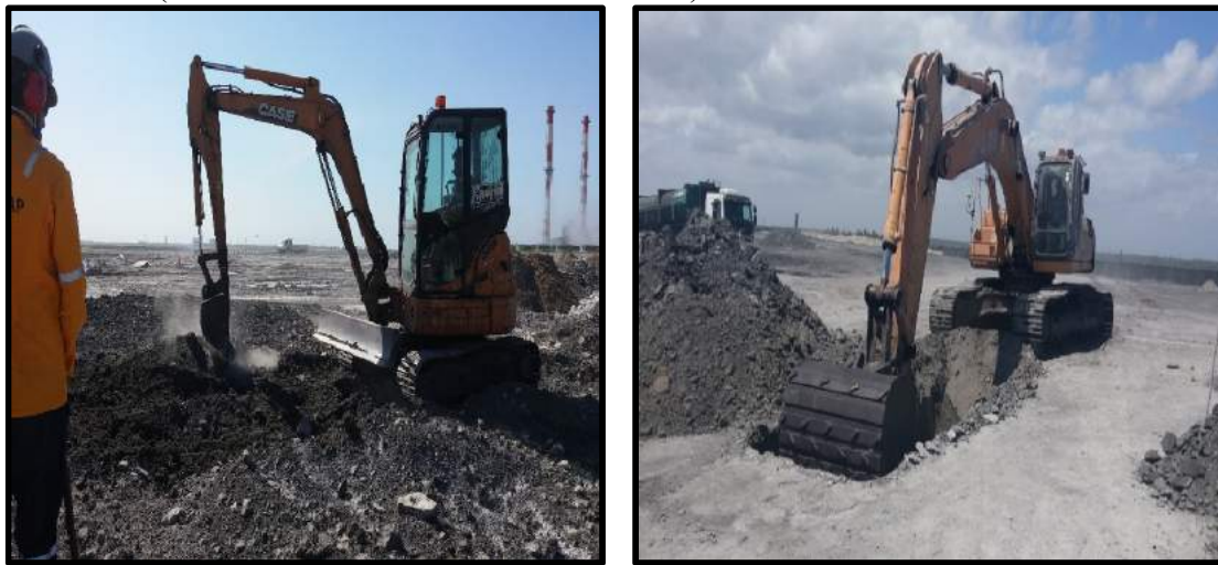
Figura 26 - (a) Mini escavadeira (Fab. Case Construcion / Mod. CX55B ); (b) Escavadeira Hidráulica (Fab. Case Construcion / Mod. CX350B ).
