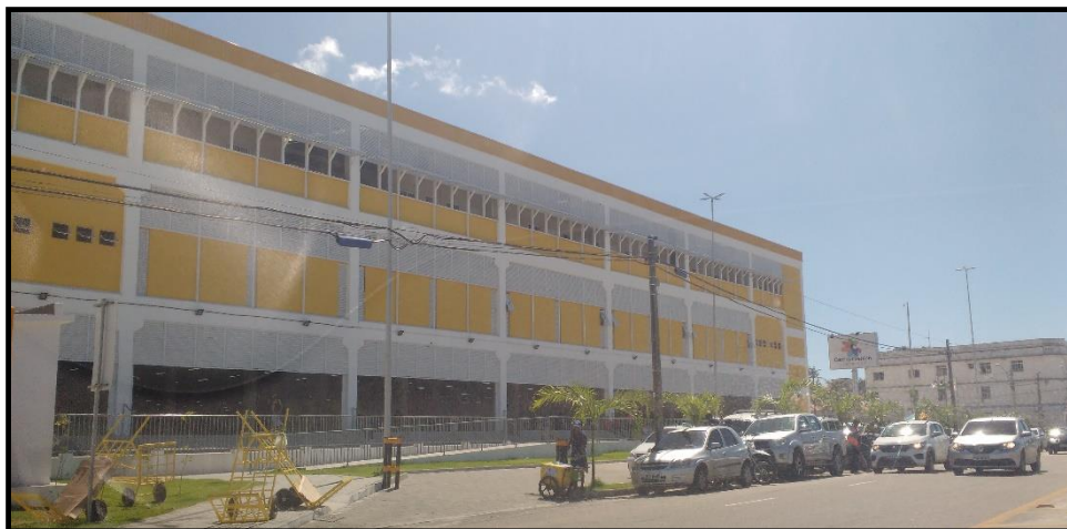
Figura 25 – Fachada do Centro Fashion. Avenida Philomeno Gomes
