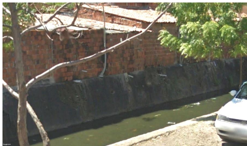
Figura 23 – Despejo de Esgoto 1
