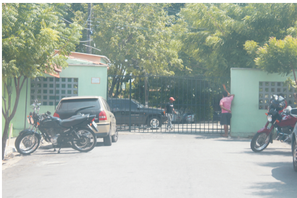
Fig. 06 - Entrada Complexo Integrado de Atendimento.
