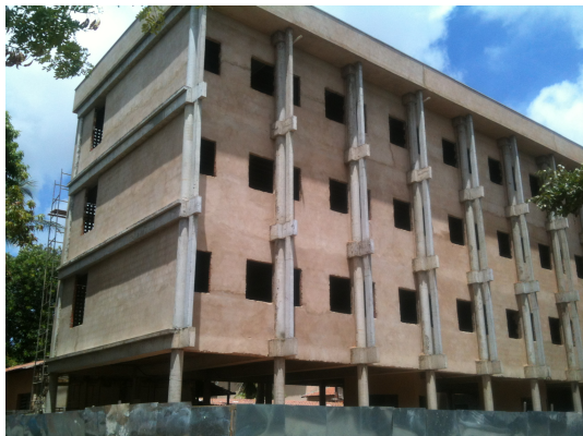
FIGURA 01 - Bloco didático de Letras e Cultura Francesa em construção
