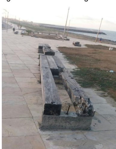
Figura 50 – Ferragens expostas. Figura 51 – Bancos desgastados. Figura 52 – Pisos quebrados.
