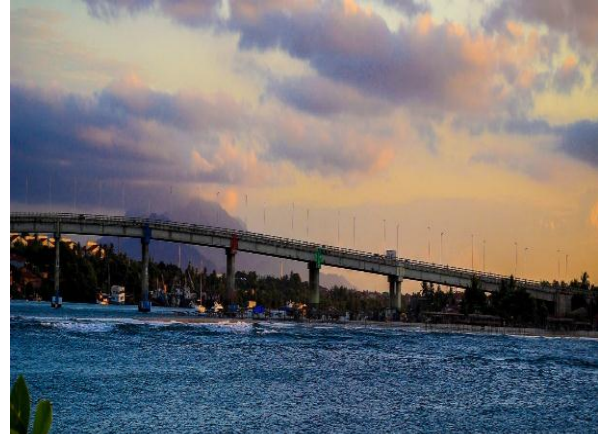
Figura 14 – Ponte José de Souza Martins, 2018.
