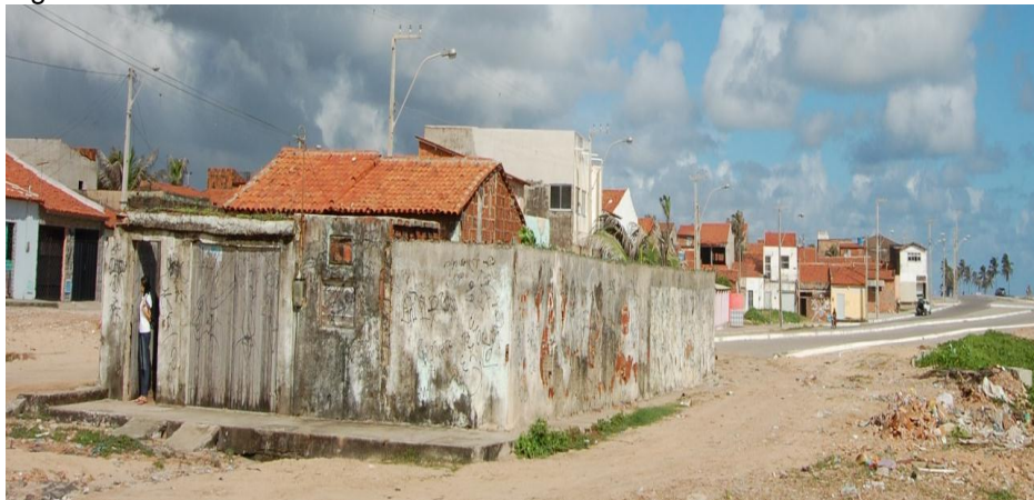
Figura 20 – Casa da Dona Íris antes de ser Demolida.
