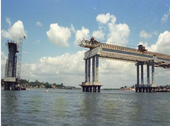
Figura 13 – Ponte José de Souza Martins, 1996.
