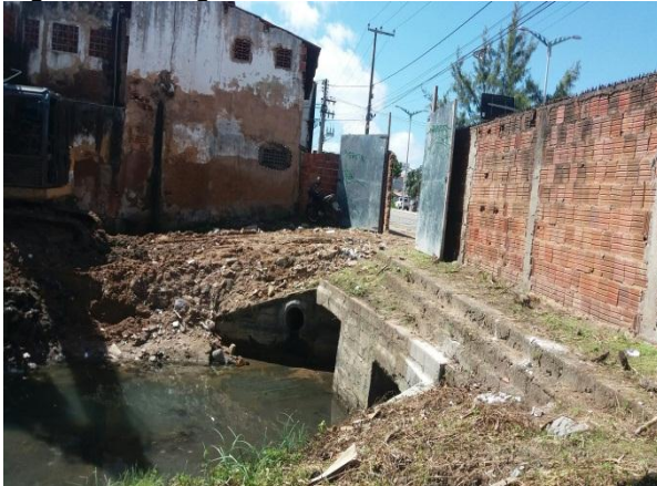
Figura 11 – Lagoa do Mel canalizada.
