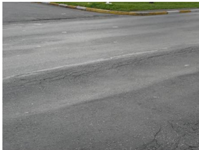
Figura 4 – Representação de deformação permanente. (Fonte: Bernucci et al. , 2007)
