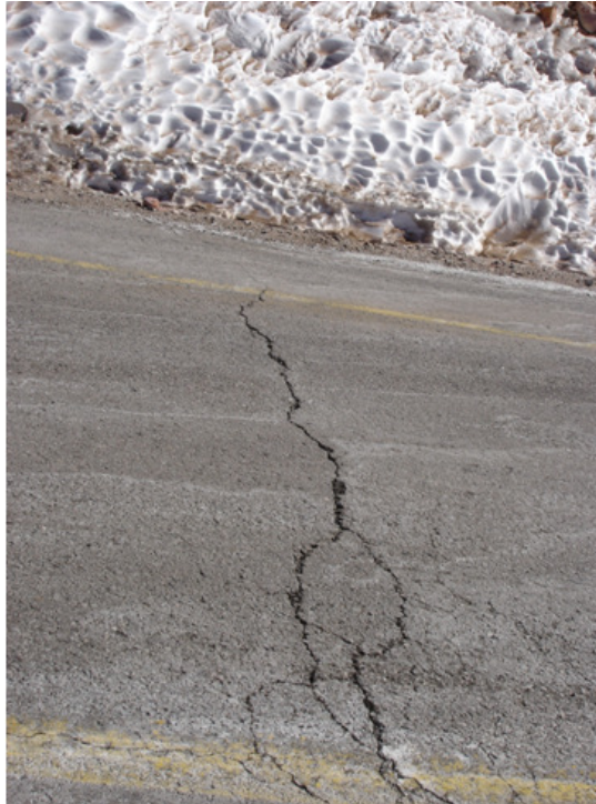
Figura 3 – Representação de trinca térmica. (Fonte: Bernucci et al. , 2007).
