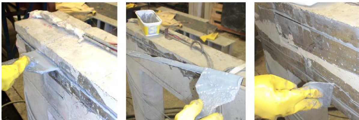
Figura 17 – Aplicação do reforço de PRFC no entalhe.
