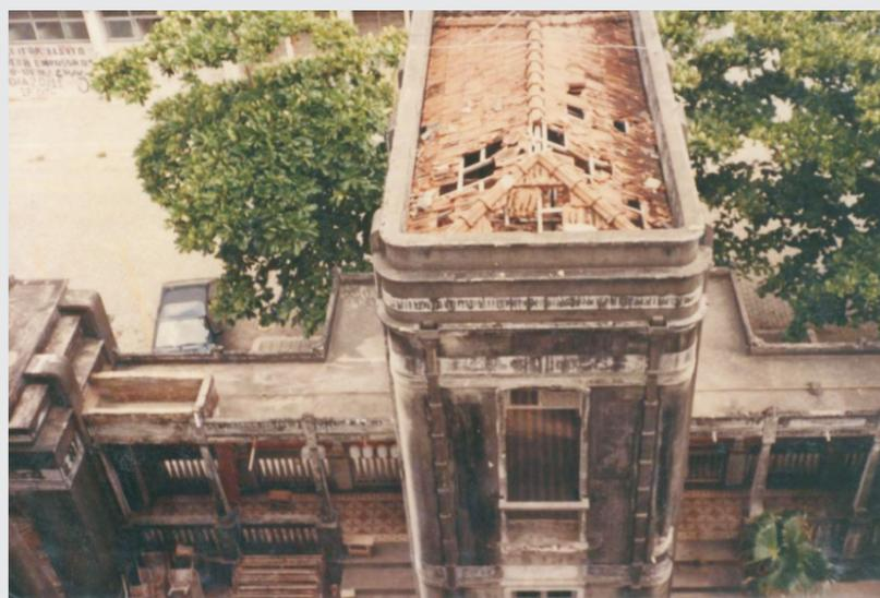
Fig.51 - Nível de degradação do edifício anexo.
