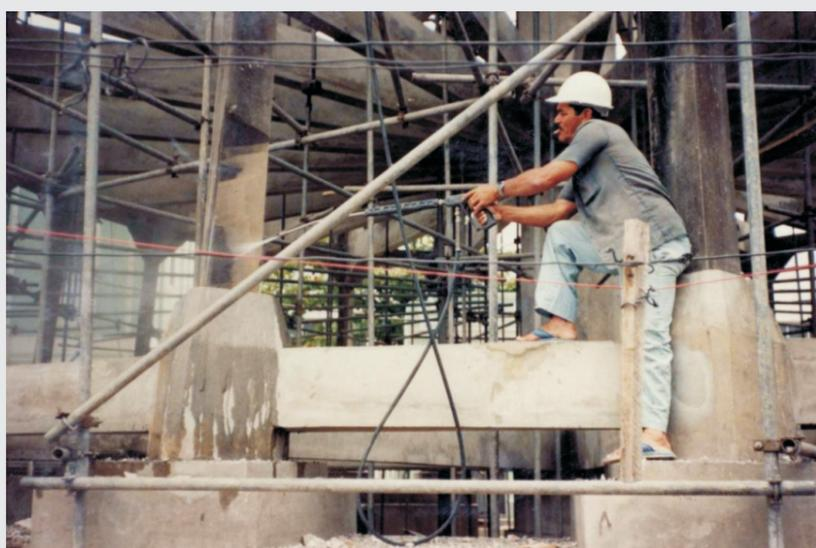
Fig.47 - Lavagem da estrutura para retirada de fuligem e pilações.
