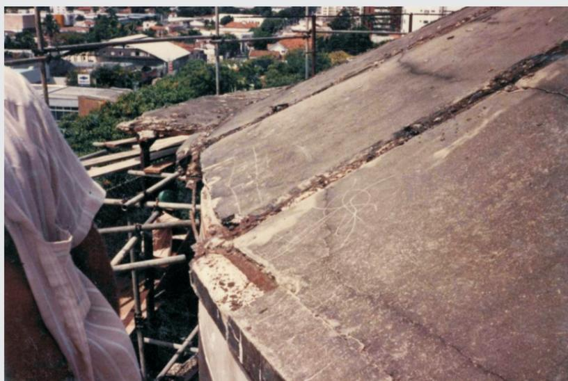
Fig.38 - Parte dos beirais perdidos devido deterioração da estrutura.
