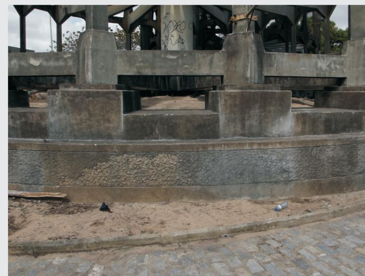
Fig.71 - Vista do anel em concreto que embasa a estrutura.
