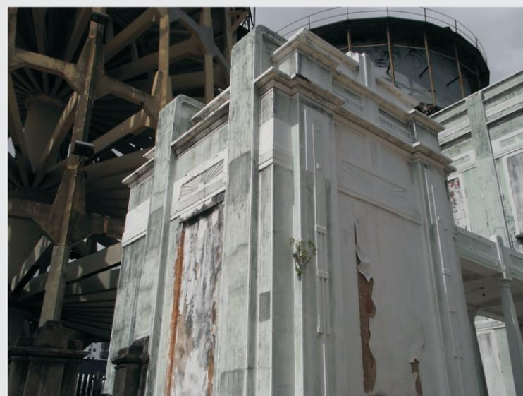
Fig.70 - Estado de deterioração do bloco lateral no edifício.
