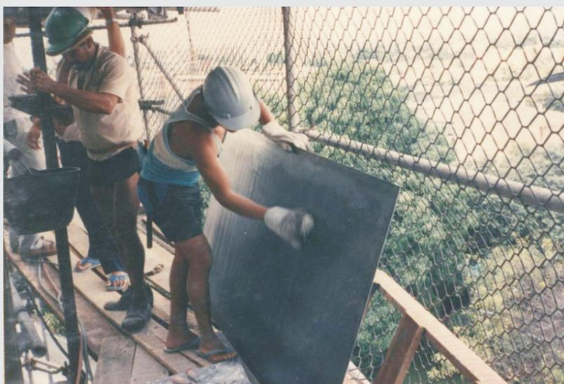
Fig.42 - Recolocação das chapas metálicas que compunham o reservatório.
