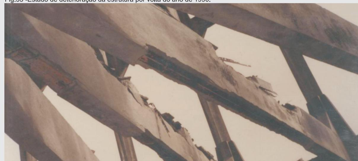
Fig.34 -Estado de deterioração das vigas radiais por volta do ano de 1990.
