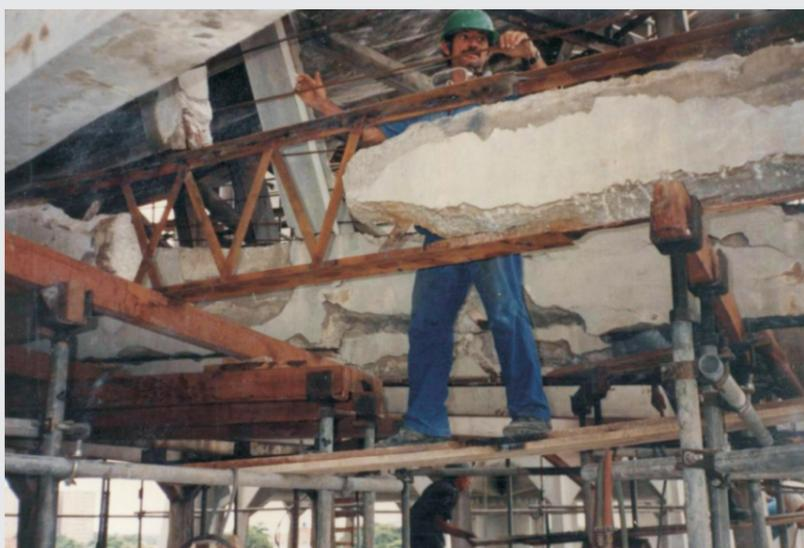
Fig.39 - Detalhe de recuperação das vigas com oxidação na estrutura metálica.
