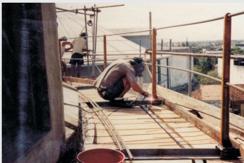
Fig.44 - Fixação dos guarda-corpos de proteção na cobertura.
