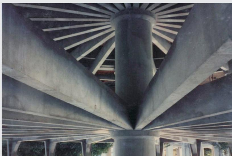
Fig.50 - Vista do encontro do pilar central com vigas radiais após restauro.
