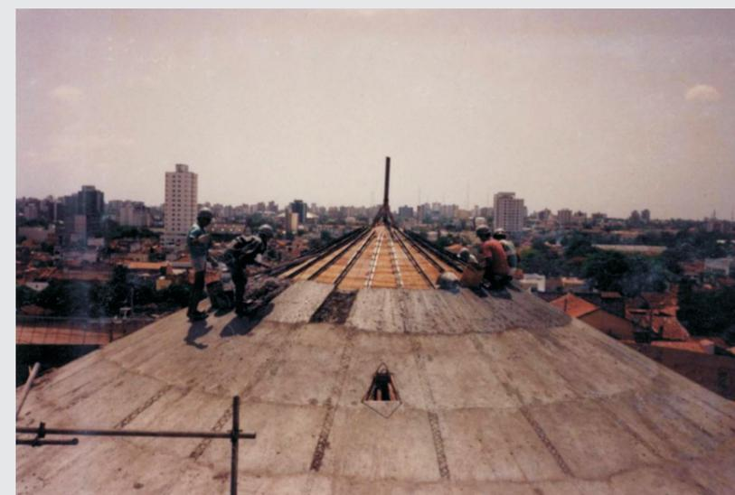
Fig.43 - Finalização da concretagem da cobertura.
