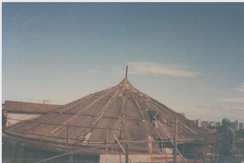
Fig.35 - Detalhe da cobertura do reservatório que estava entrando em colapso.
