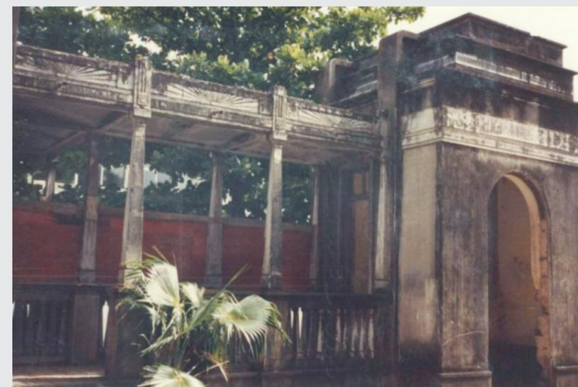
Fig.46 - Detalhe mostrando a falta de esquadrias no edifício.
