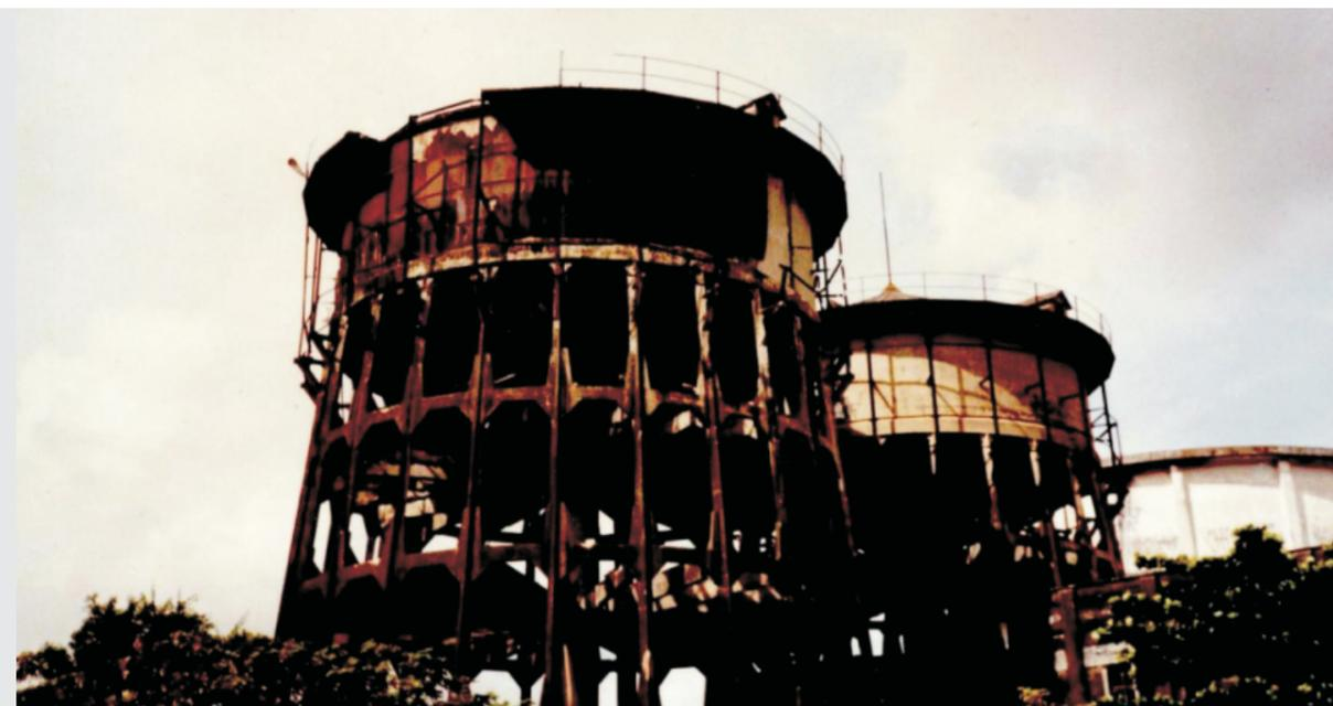
Fig.32 -Estado de deterioração da estrutura por volta do ano de 1990.
