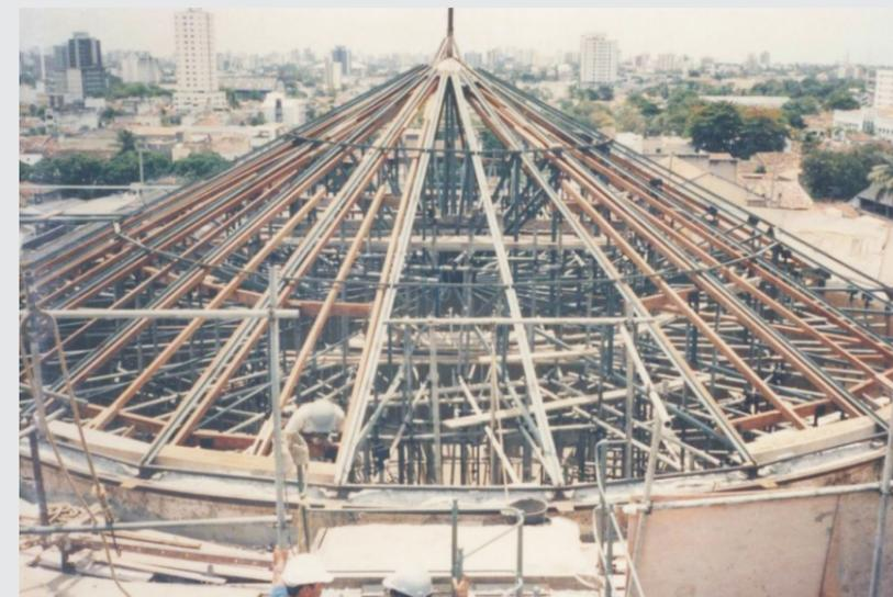
Fig.37 - Detalhe das tesouras metálicas que sustentam a cobertura.
