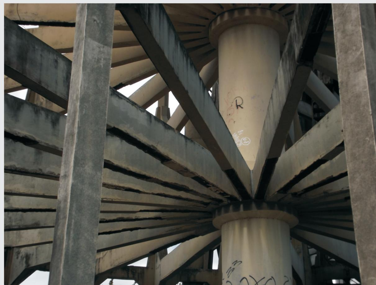
Fig.58 - Detalhe do estado atual das vigas radiais dos reservatórios.
