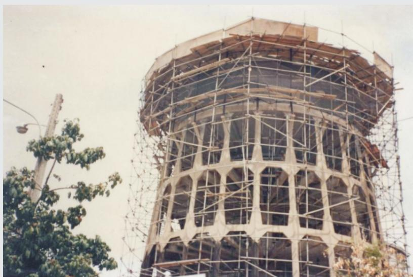
Fig.41 - Apoio de toda a estrutura para início da obra de restauro.
