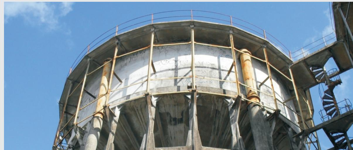
Fig.01 - Vista da caixa d'água mostrando o seu estado atual de conservação.
