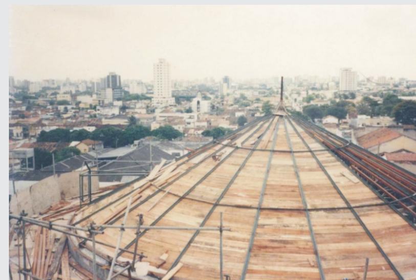
Fig.40 - Preparação da forma para concretagem.
