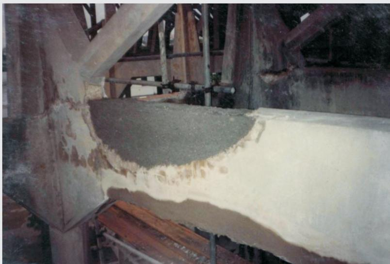
Fig.36 - Detalhe da recuperação das vigas radiais com concreto trincado.
