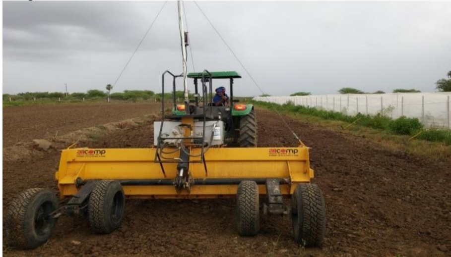
Figura 6 – Sistematização com nivelamento da superfície do solo em desnível na Unidade Operativa de Jaguaruana – CE.
