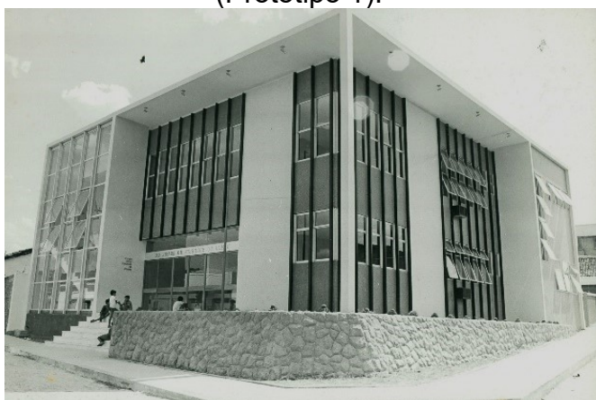
Figura 3.44 – Edifício de Guanambi-BA (Protótipo 1).
