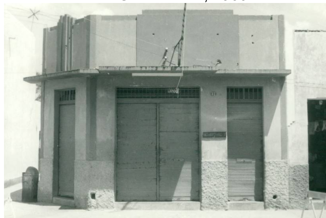
Figura 2.14 - Antigo edifício da agência de Mata Grande - AL, 1960.
