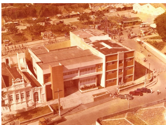
Garanhuns-PE, vista aérea do edifício do BNB ao centro, 1976.
