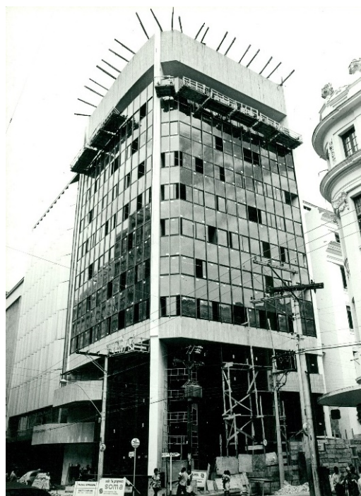
Salvador-BA em construção, 1972.
