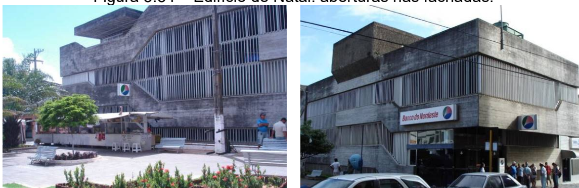
Figura 3.54 – Edifício de Natal: aberturas nas fachadas.
