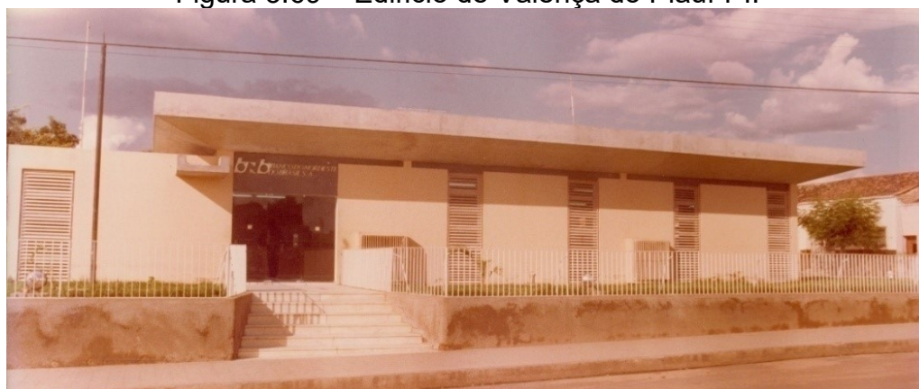
Figura 3.69 – Edifício de Valença do Piauí-PI.
