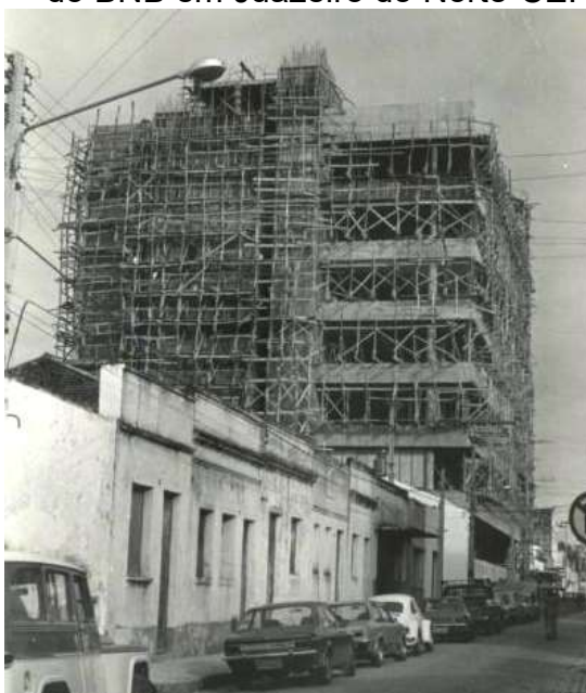
Figura 1.32 - Construção da agência do BNB em Juazeiro do Norte-CE.
