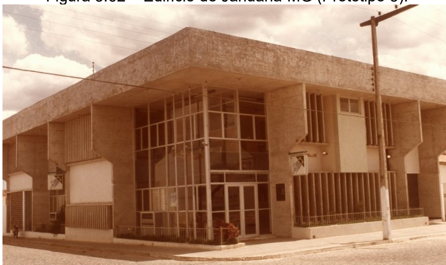
Figura 3.62 – Edifício de Januária-MG (Protótipo 3).
