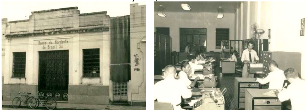
Figura 2.7 - Aspecto externo e interno do primeiro edifício do BNB em Aracaju-SE, 195?
