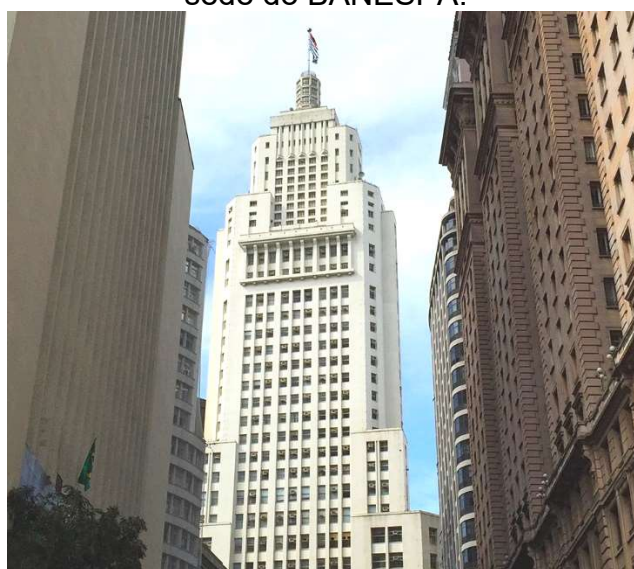
Figura 1.9 - Edifício Altino Arantes, antiga sede do BANESPA.
