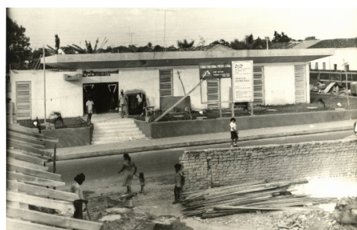
Construção do edifício de Valença do Piauí, 1978.
