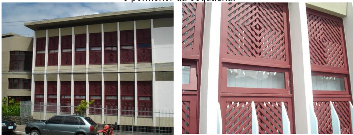
Figura 3.37 – Edifício de Penedo: trecho da fachada leste e pormenor da esquadria.
