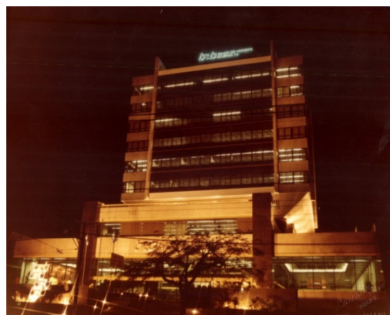
Edifício Apolônio Sales, Recife-PE, 1984.
