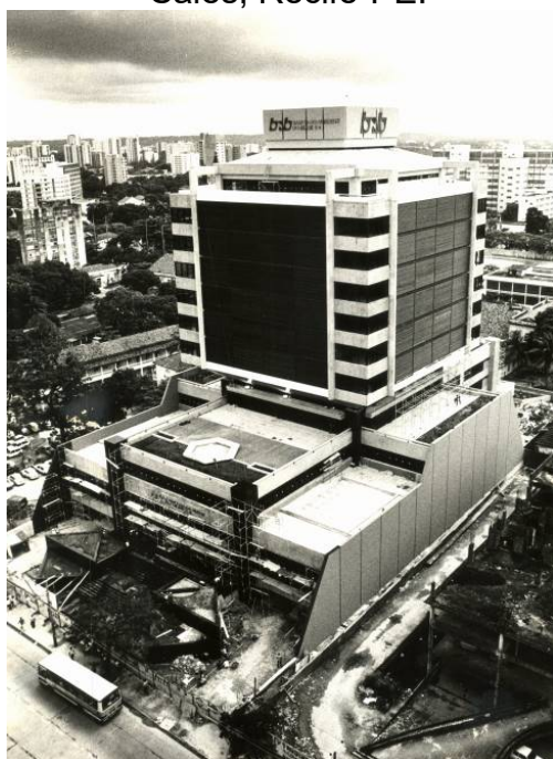
Figura 2.34 – Edifício Apolônio Sales, Recife-PE.
