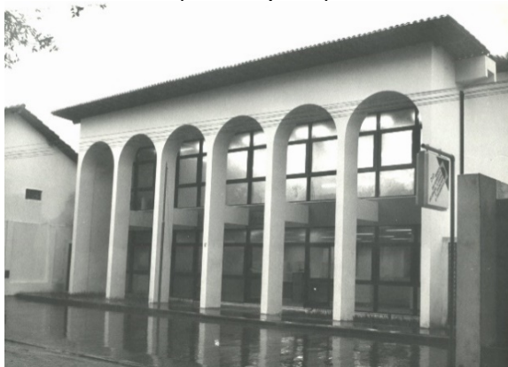
Figura 3.47 – Edifício de Paulista-PE (Protótipo 4).
