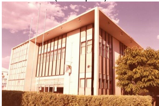
Figura 3.30 – Edifício de Iguatu-CE (Protótipo 1)
