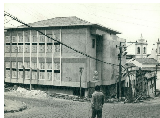
Edifício de Penedo-AL em construção, 1978.
