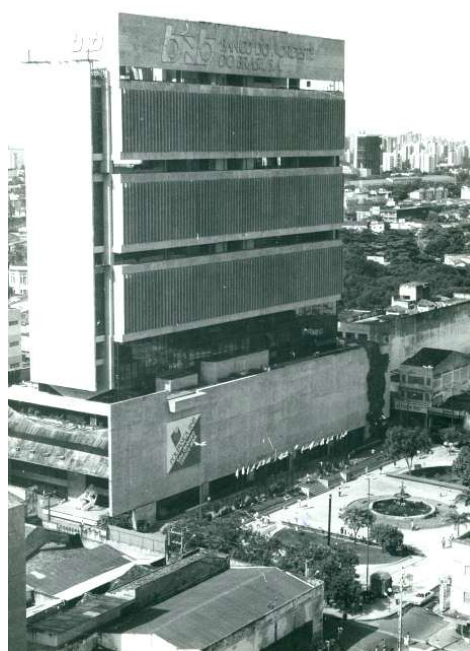
Figura 2.35 – Edifício Raul Barbosa, Fortaleza-CE.
