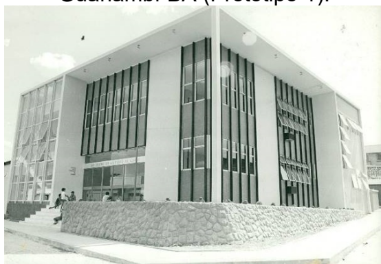
Figura 3.5: Edifício da agência de Guanambi-BA (Protótipo 1).
