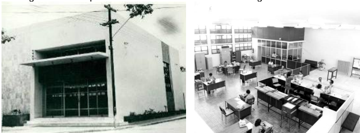
Figura 2.15 - Aspecto externo e interno do edifício da agência Canindé-CE.
