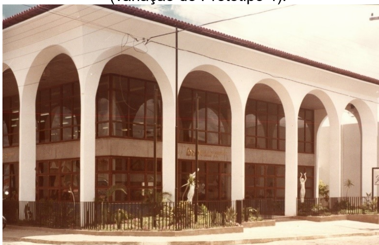
Figura 3.49 – Edifício de Simão Dias-SE (variação do Protótipo 4).
