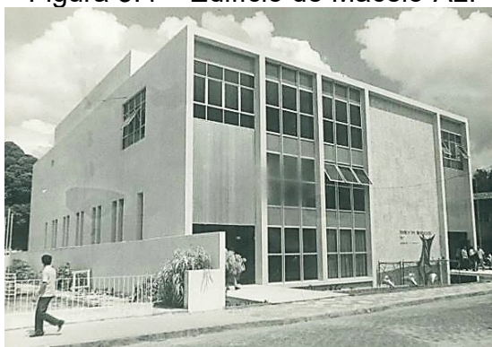
Figura 3.4 – Edifício de Maceió-AL.
