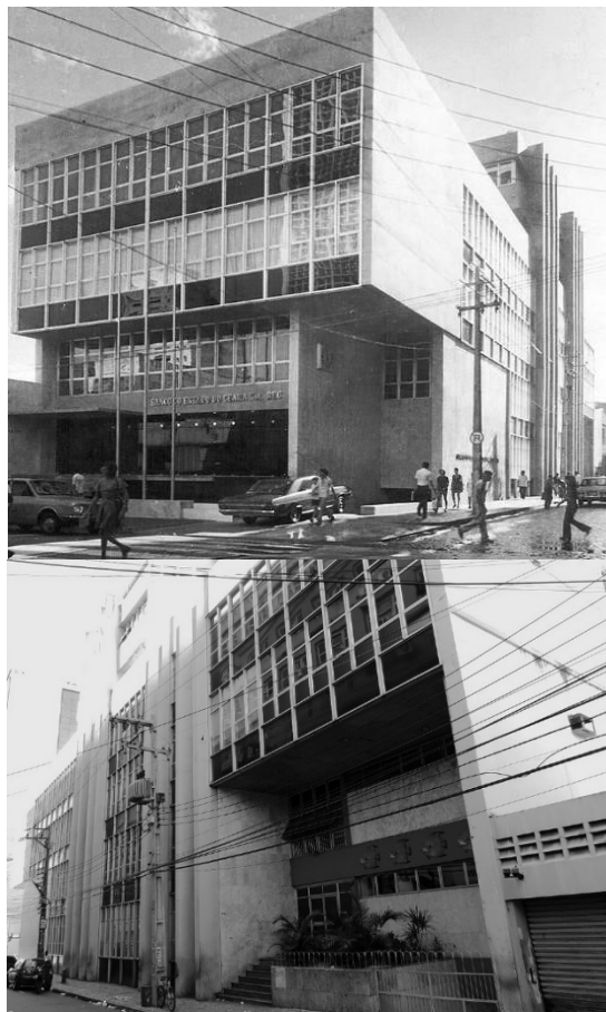
Figura 1.39 - Edifício-sede do BEC, Fortaleza-CE.
