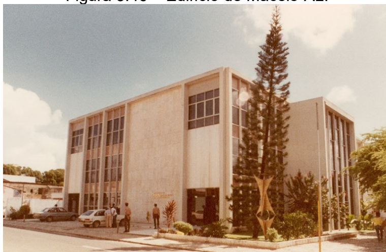
Figura 3.46 – Edifício de Maceió-AL.
