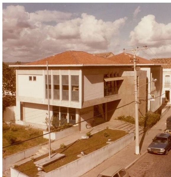
Figura 3.10: Edifício da agência de Penedo-AL.
