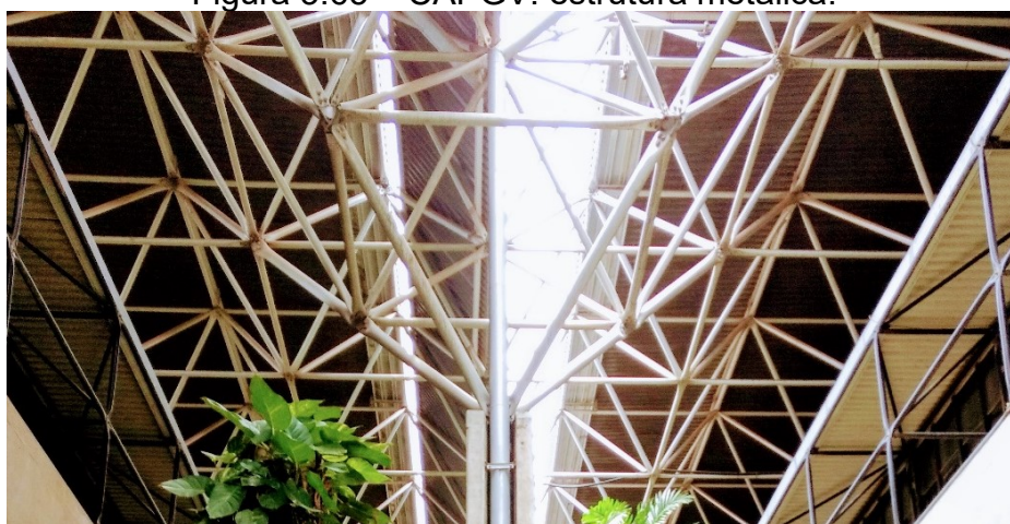
Figura 3.65 – CAPGV: estrutura metálica.
