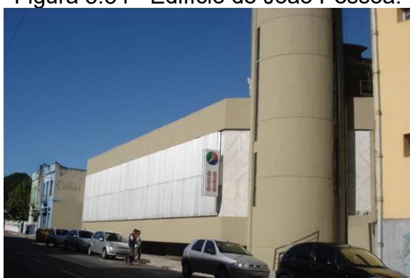
Figura 3.34 - Edifício de João Pessoa.
