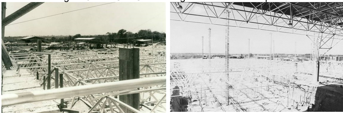
Figura 3.41 – CAPGV: montagem da estrutura espacial.
