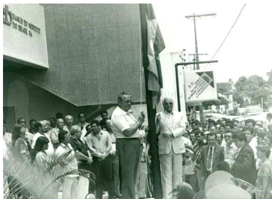
Figura 2.33 - Inauguração do edifício de São Antônio de Jesus-BA, 1985.
