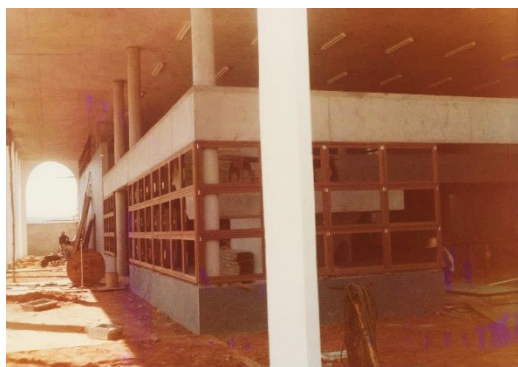
Edifício de Simão Dias-SE em construção, 1985.
