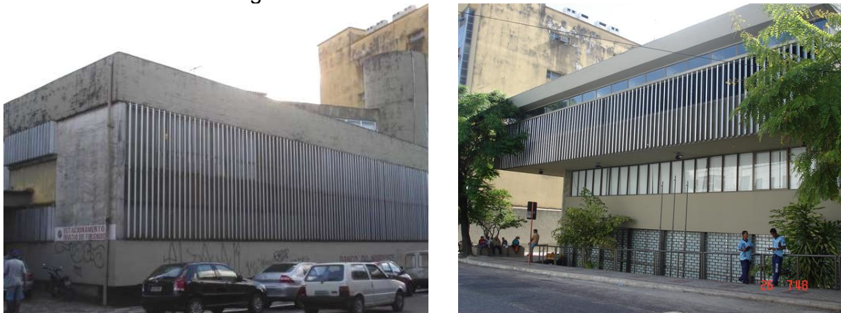
Figura 3.76 – Edifício de João Pessoa.
