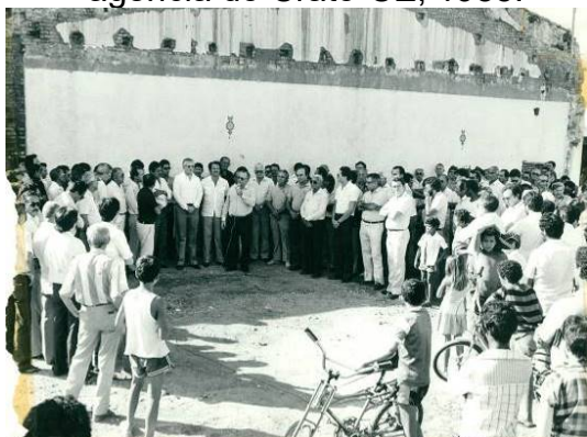
Figura 2.32 - Lançamento da pedra fundamental do novo edifício da agência do Crato-CE, 1985.
