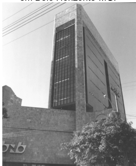
Figura 1.34 - Edifício do BNB em Belo Horizonte-MG.
