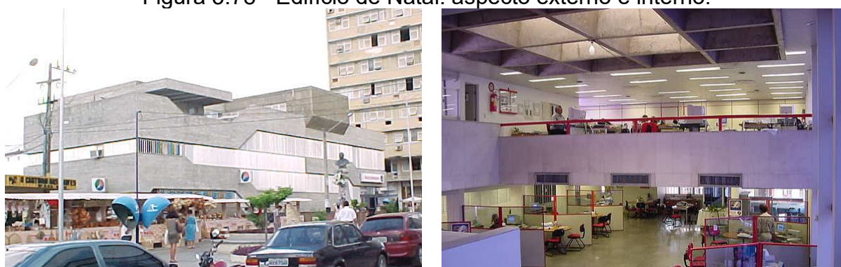
Figura 3.78 - Edifício de Natal: aspecto externo e interno.
