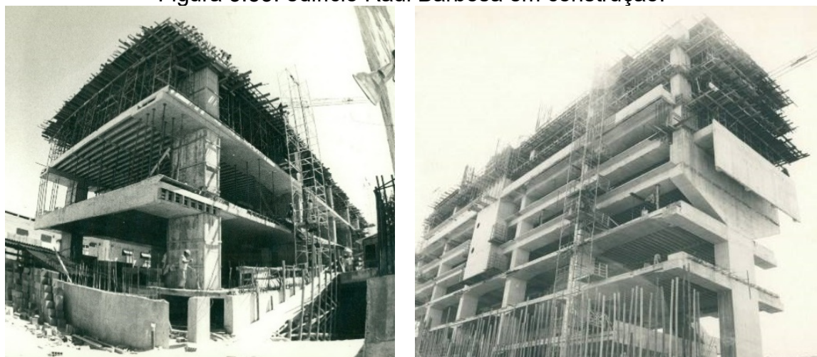
Figura 3.53: edifício Raul Barbosa em construção.
