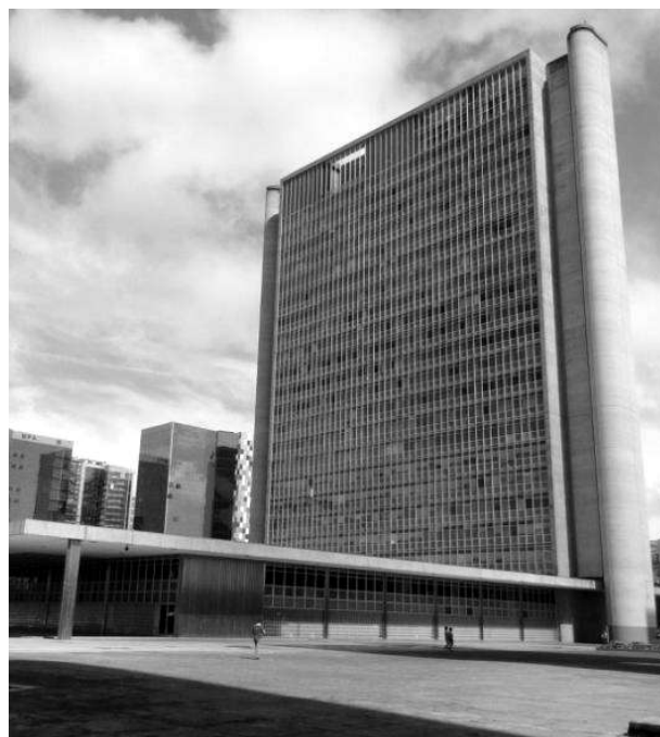
Figura 1.26 - Edifício Sede I do Banco do Brasil, Brasília – DF.
