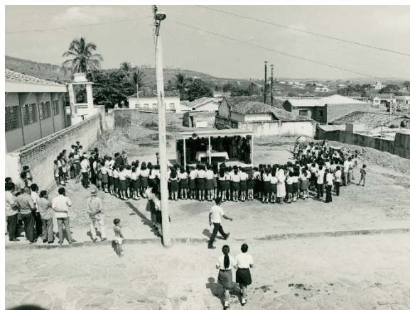
Lançamento da pedra fundamental da obra para construção do edifício de Salinas-MG.
