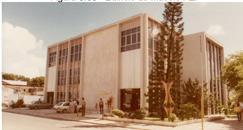
Figura 3.68 - Edifício de Maceió-AL.
