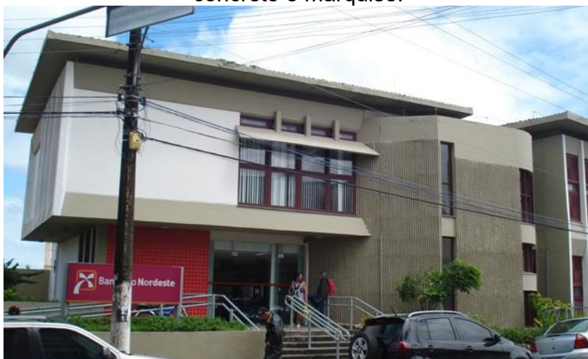
Figura 3.51 - Edifício de Penedo: brise de concreto e marquise.
