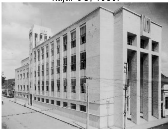
Figura 1.7 - Agência do Banco INCO, Itajaí-SC, 1950.
