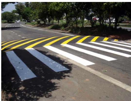
Figura 16: Exemplo de aplicação de ondulação transversal
