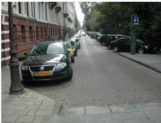
Figura 20: Alargamento de calçada na esquina.
