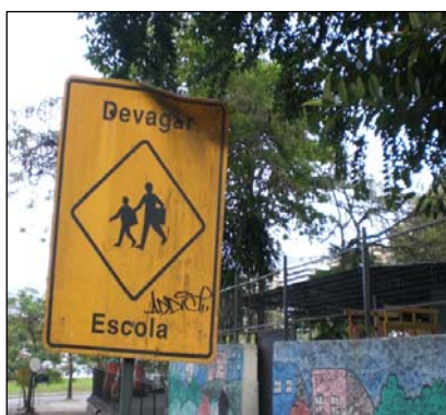
Figura 14: Placa composta de área escolar (A32a) com diversas avarias
