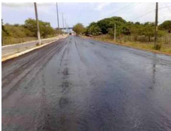
Figura 2.8 - Imprimação em uma camada de base.
