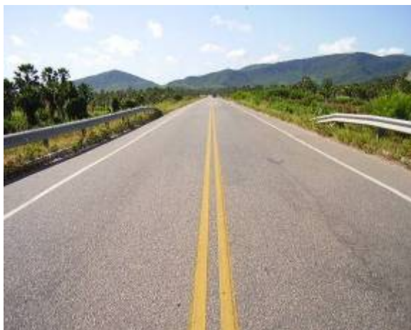
Figura 2.3 - Foto de uma rodovia em TSD.
