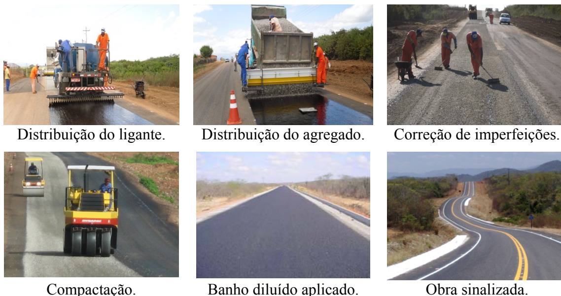
Figura 2.15 - Seqüência de fotos ilustrativas das etapas construtivas de um TS.
