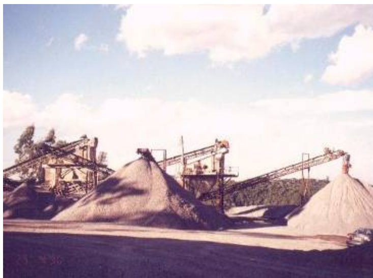
Figura 2.11 - Britagem do agregado.
