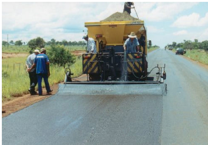
Figura 2.4 - Aplicação de uma capa selante em serviço de conservação (ROMANELLI, 2009).
