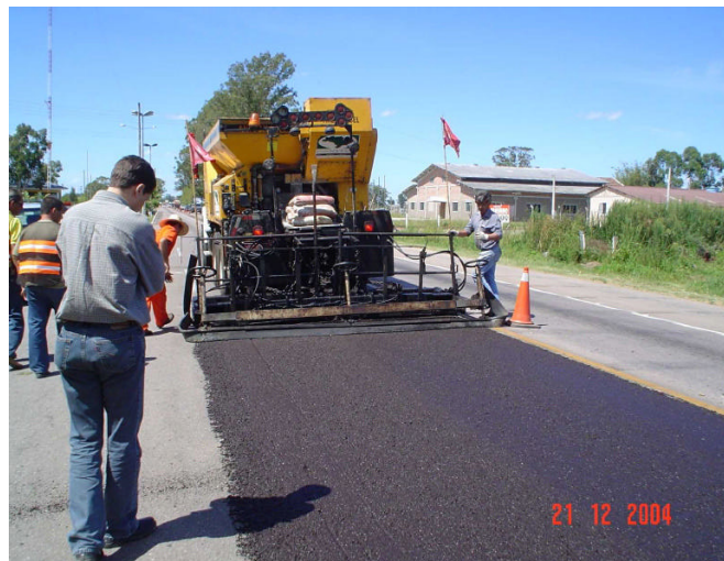
Figura 2.6 - Aplicação de um micro revestimento asfáltico (ECOSUL S/A, 2009).
