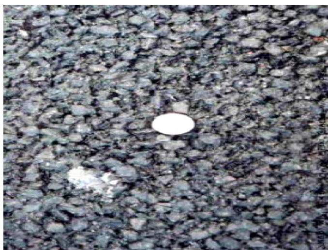
Figura 2.7 - Detalhes da textura de um macadame betuminoso.
