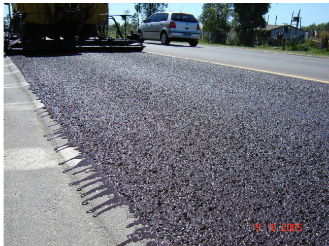
Figura 2.5 - Aplicação de uma lama asfáltica (ECOSUL S/A, 2009).
