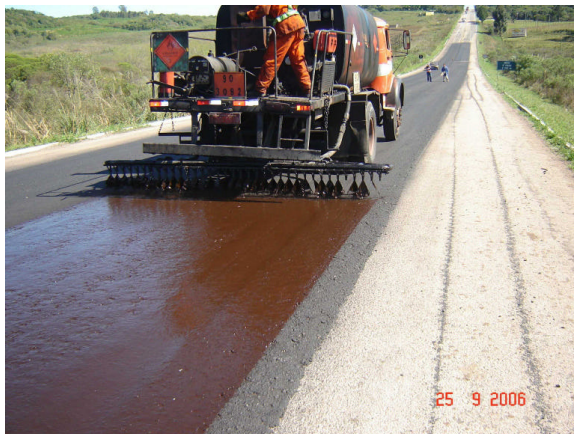
Figura 2.9 - Pintura de ligação (ECOSUL S/A, 2009).
