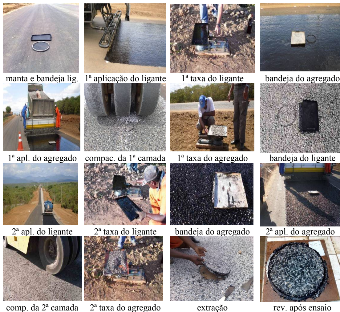
Figura 4.31 - Procedimentos usados na aplicação e moldagem do revestimento.
