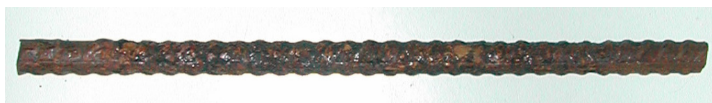
Figura 4.14 (b) - Barra de aço depois de retirada do concreto.
