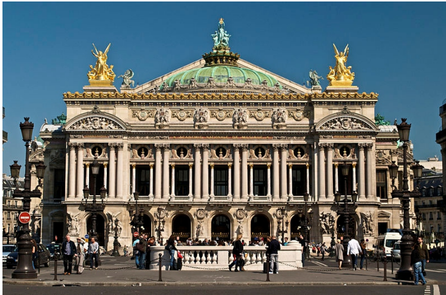
Figura 03 - Fachada do Palais Garnier
