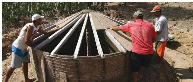
FIGURA 24: Técnica de construção das cisternas. Placas de solo-cimento, mão-de-obra local. FONTE: Relatório Social FEBRABAN - 2010.
