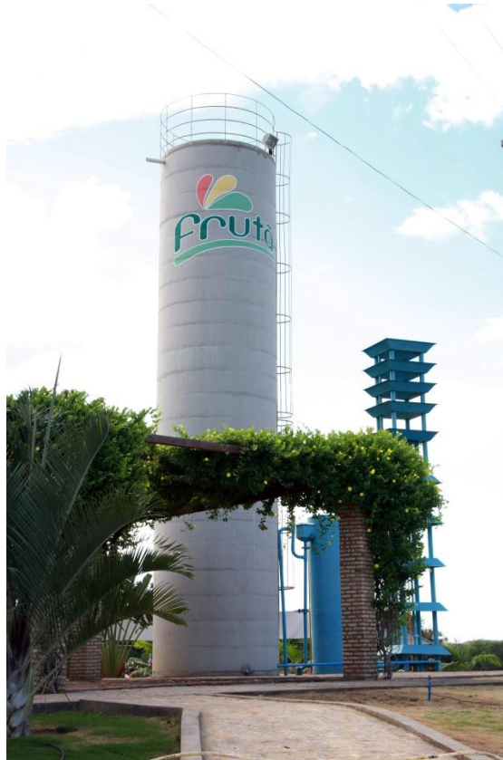
FIGURA 2 – Caixa d'água e estação de tratamento.
