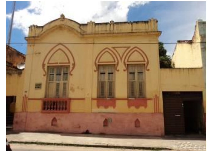
Figura 45: Fachada da HCPA-37.
