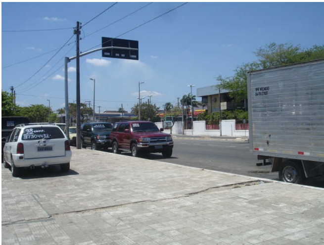
Fig. 22: Pavimentação da praça e da Av. Gomes Brasil. Fonte: Arquivo pessoal, 2010.
