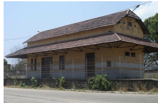
Fig. 19: Estação da Parangaba antes do rebaixamento. Fonte: Arquivo pessoal, 2008.
