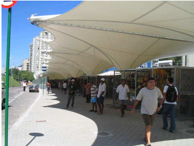
Fig. 6: Mercado Popular da Rocinha. Fonte: http://obras.rio.rj.gov.br .
