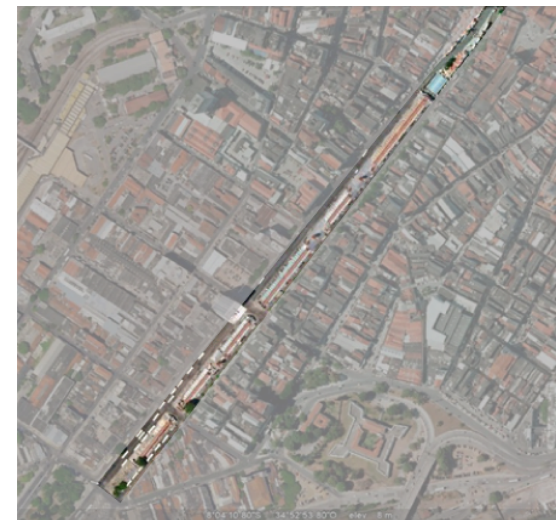
Fig. 3: Vista aérea do Calçadão dos Macacates. Fonte: Google earth.
