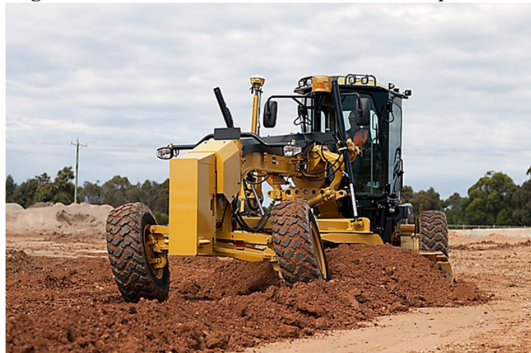
Figura 2.3 - Motoniveladora em atividade de espalhamento
