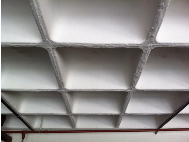
Figura 9 - Aspecto dos vazios e nervuras da laje nervurada
