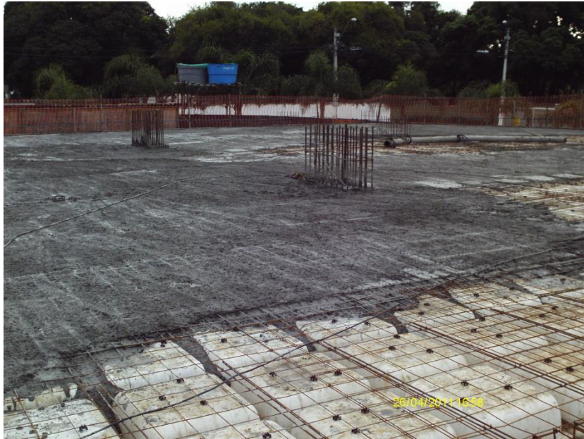
Figura 12 - Concretagem de uma laje nervurada
