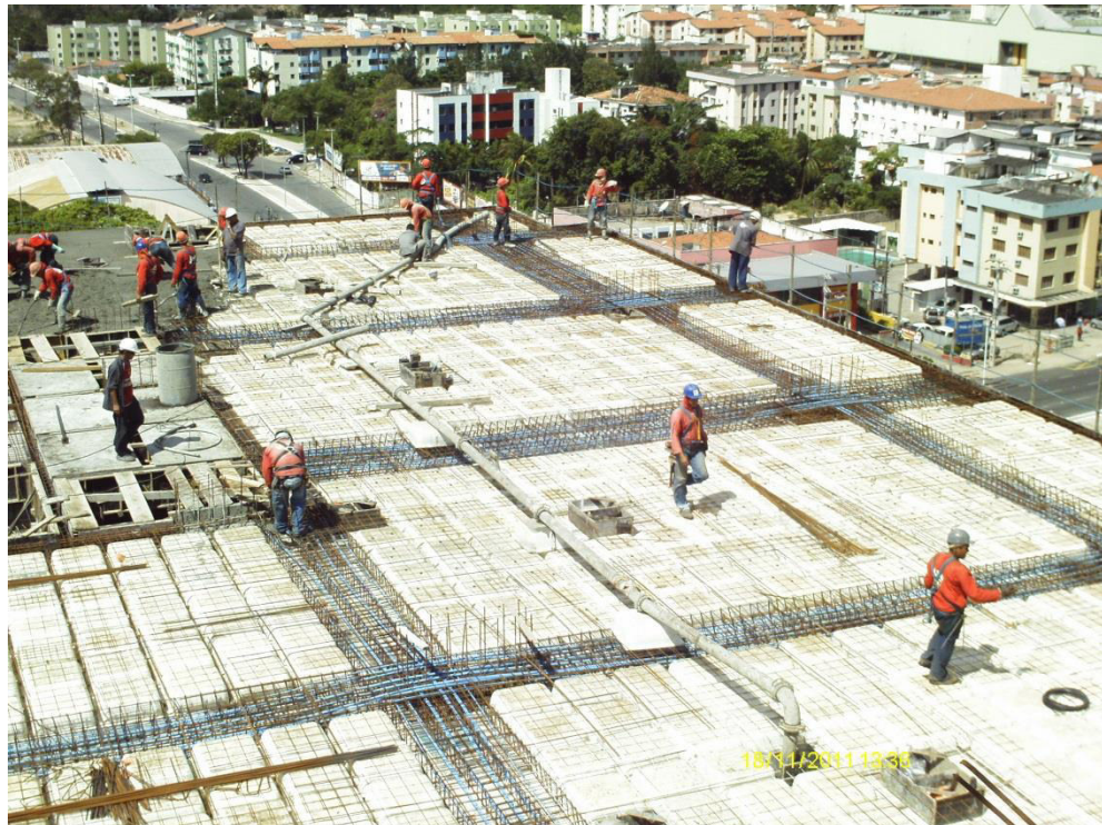
Figura 19 - Fixação dos moldes e concretagem da laje
