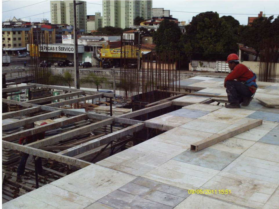
Figura 18 - Colocação das plataformas plásticas
