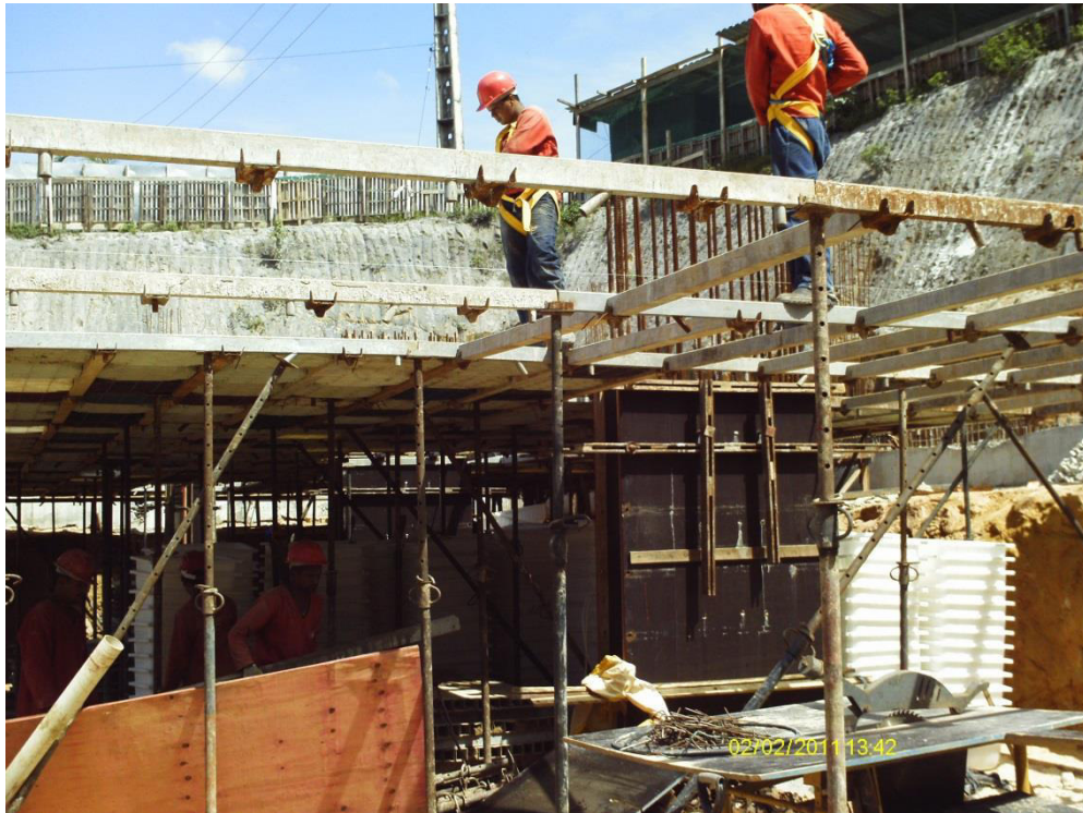
Figura 17 - Cimbramento metálico
