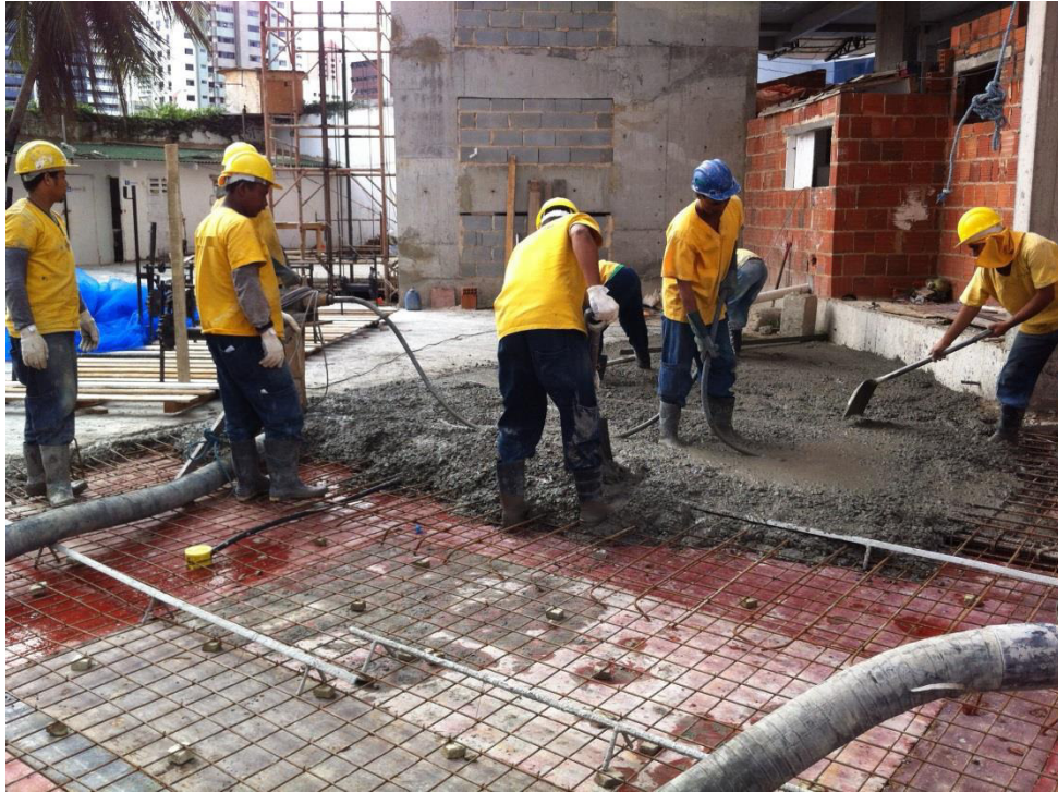
Figura 8 - Concretagem de laje maciça
