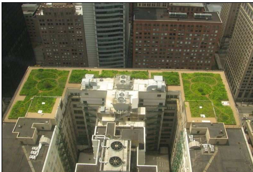
Figura 6 – Telhado verde do City Hall de Chicago.
