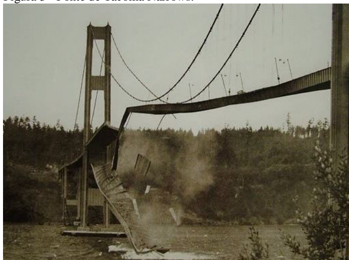
Figura 3 - Ponte de Tacoma Narrows.
