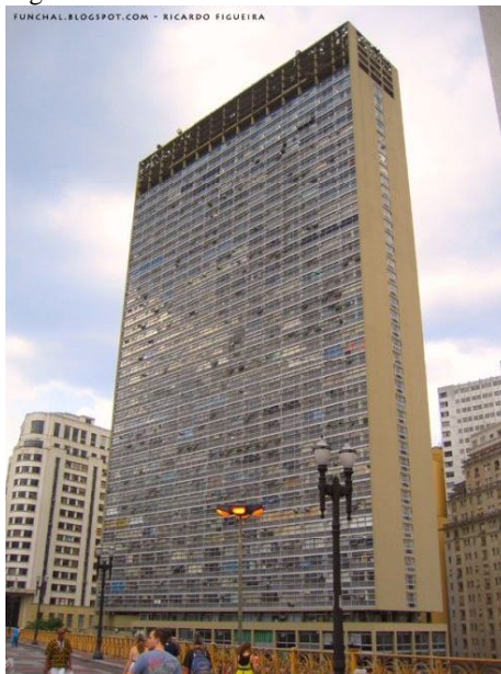
Figura 2 - Edifício Mirante do Vale.
