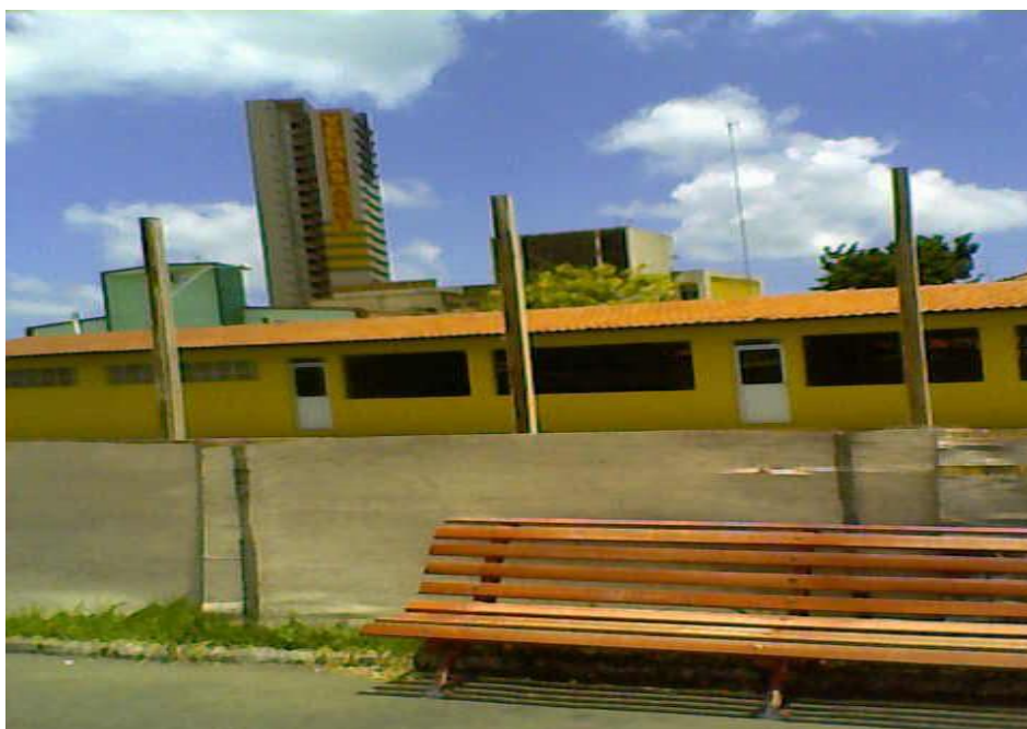
Fig. 27 – 2009 – Depósito do Corpo de Bombeiros construído no local do antigo SAPS Fonte: Arquivo pessoal da pesquisadora
