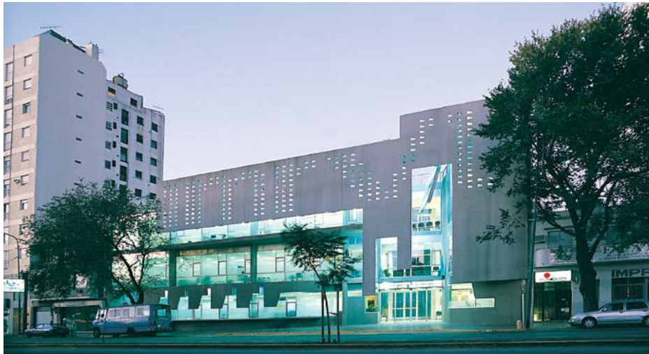
Figura 01 - Vista da fachada, onde se pode avistar a tela com as letras, formando o nome do Centro - Fonte: http://www.arcoweb.com.br/arquitetura//arquitetura623.asp (Junho/2007)
