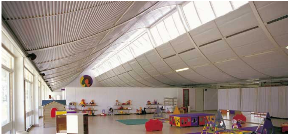
Figura 05 – Sheds no Sarah do Rio de Janeiro, janelas que fazem a ventilação natural - Fonte: Revista Projeto Design Ed. 266 (Abril/2002)
