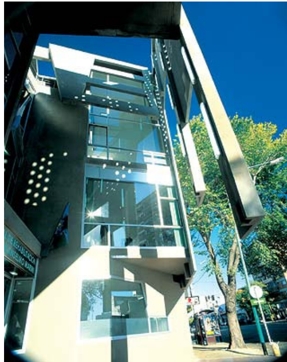
Figura 03 – Tela de concreto da fachada, formando brises e janelas da fachada de tamanhos variados - Fonte: http://www.arcoweb.com.br/arquitetura//arquitetura623.asp (Junho/2007)
