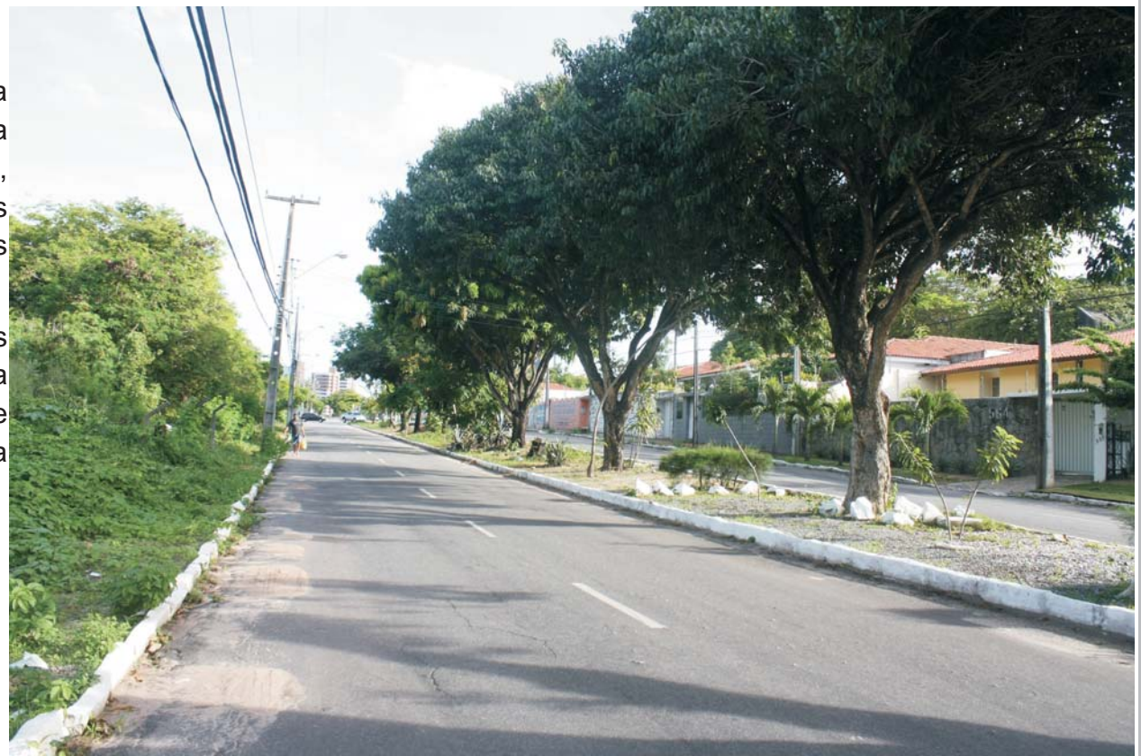
Figura 4.3.1 - Imagem Avenida Miguel Dias Fonte: Fotografia no local.
