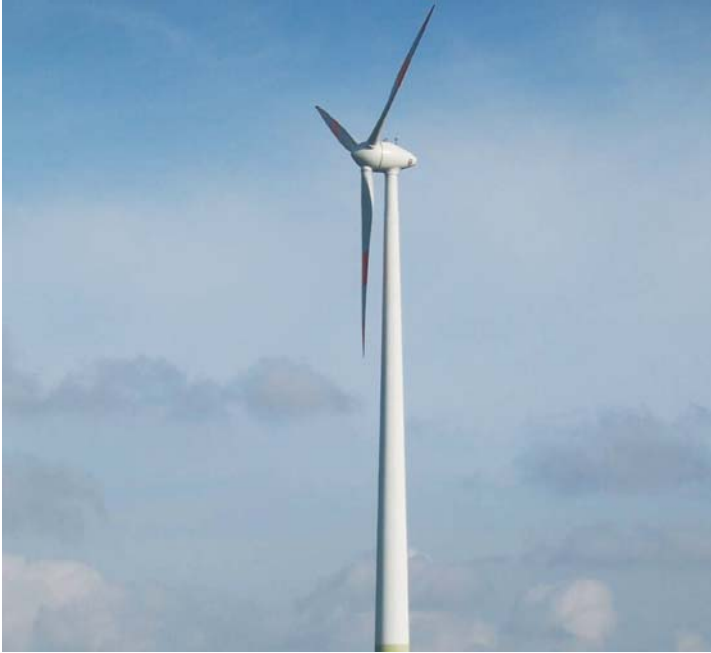
Figura 5.1.1 - Aerogerador de eixo horizontal Fonte: http://pt.wikipedia.org/wiki/Aerogerador
