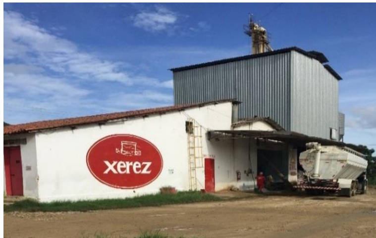
Figura 3 – Galpão único na Fábrica I
