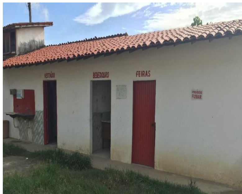
Figura 13 – Vestiário e bebedouro da Fábrica I
