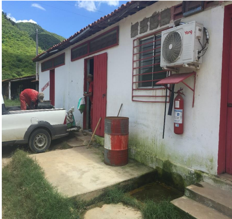
Figura 7 – Sala climatizada para o preparo de premix
