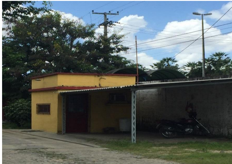
Figura 12 – Sala de administração climatizada da Fábrica III
