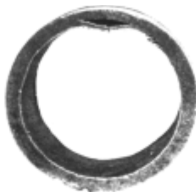
Figura 9 – Tubo de aço carbono com empolamento por hidrogênio, ocasionado por H 2 S e água.
