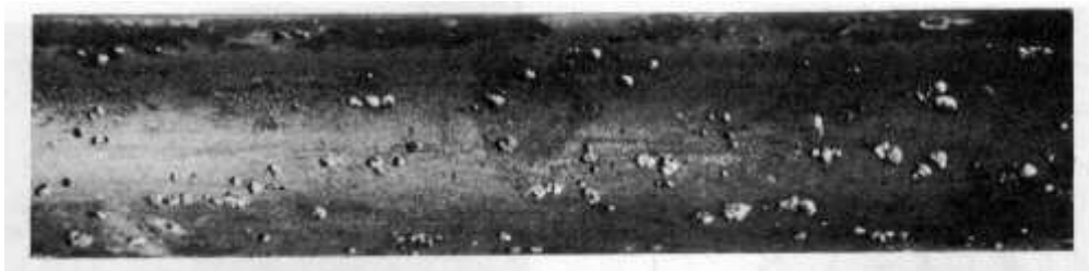
Figura 4 – Corrosão por pites em tubo de aço inoxidável AISI 304.
