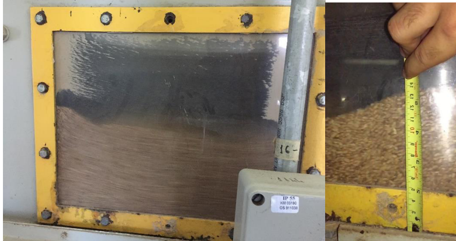
Figura 3 – Janela de Inspeção do Redler T4 e Posicionamento da Trena.
