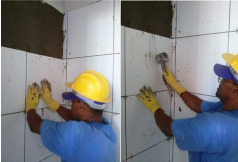
Figura 12 - assentamento das peças com a mão e com martelo.
