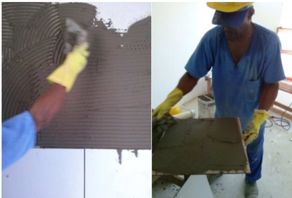
Figura 10 - dupla colagem sendo realizada ao se aplicar argamassa na peça cerâmica e na superfície de assentamento.
