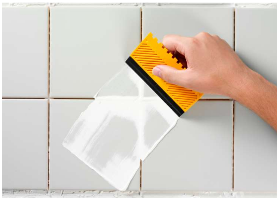
Figura 15 - aplicação de argamassa de rejunte com desempenadeira de borracha
