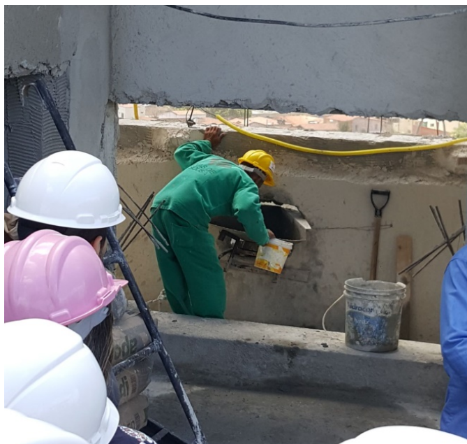
Figura 6 – lançamento da argamassa por meio de tubos.
