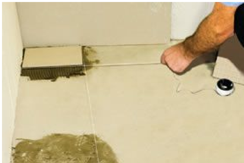
Figura 11 - linhas de náilon sendo utilizadas para definir alinhamento.
