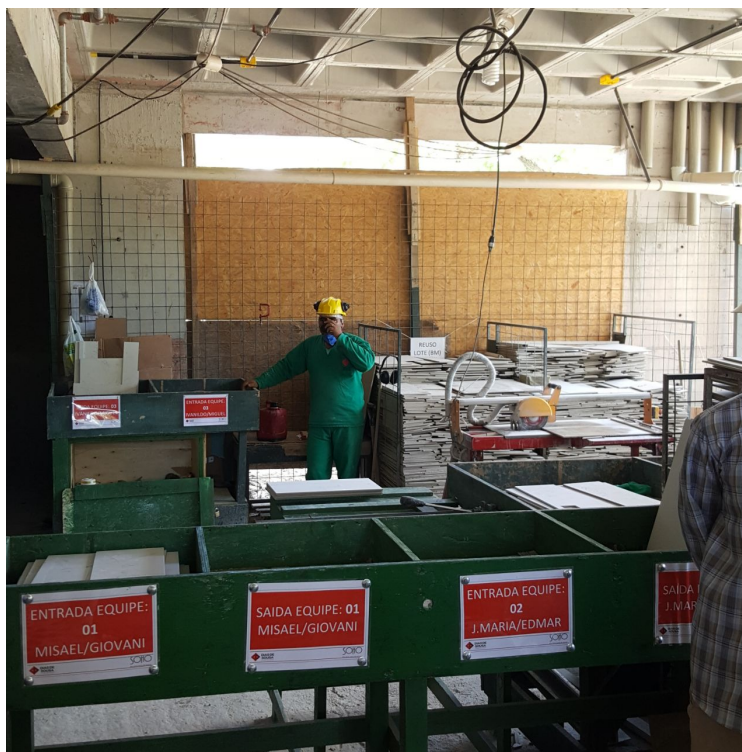
Figura 9 - Central de corte de cerâmica em obra.
