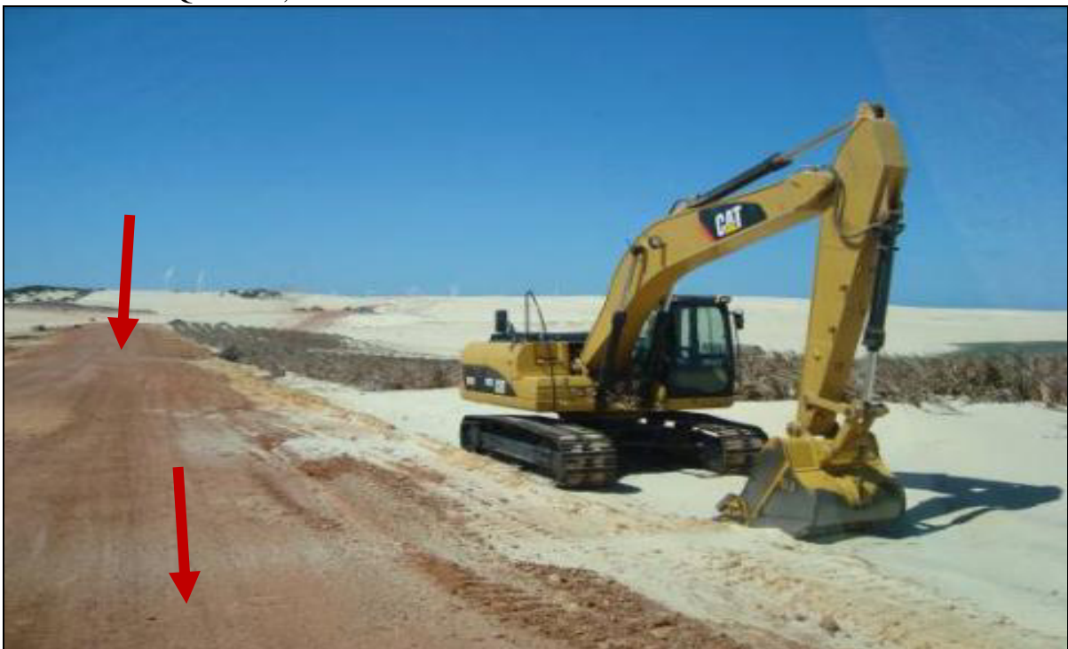
Figura 17 - Leito estradal compactado para acesso de guas e caminhões no campo de dunas Cumbe/Canoa Quebrada, Ceará.
