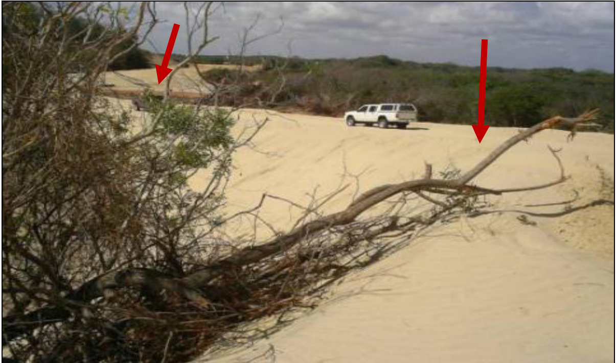
Figura 12 - Via de acesso (para os pontos onde serão instalados os aerogeradores) sobre área ocupada por uma duna fixa no campo de dunas da Taíba, Ceará.
