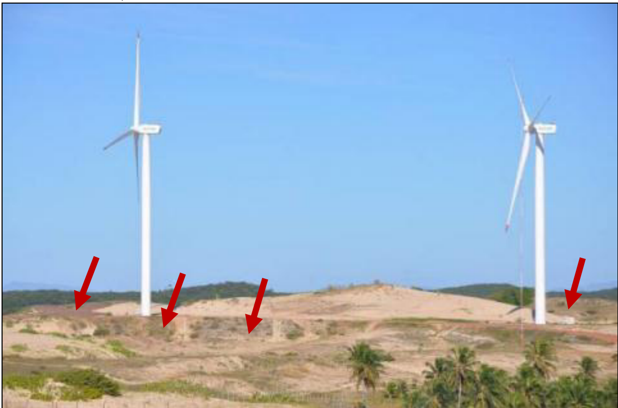
Figura 19 - Fixação artificial para viabilizar via de acesso entre dois aerogeradores no campo de dunas da Taíba, Ceará.
