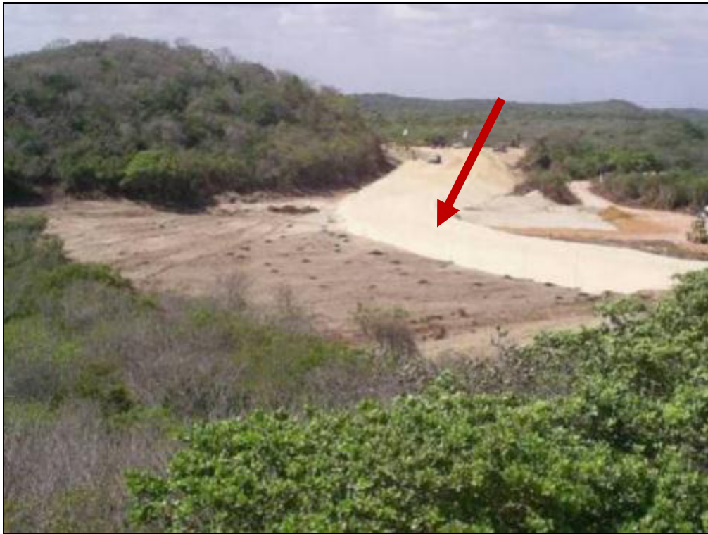
Figura 9 - Vista panorâmica do desmatamento de duna fixa: base da duna fixa retirada, com a remoção do solo para a instalação de vias de acesso de canteiro de obras no campo obras no campo de dunas na Taíba, Ceará.
