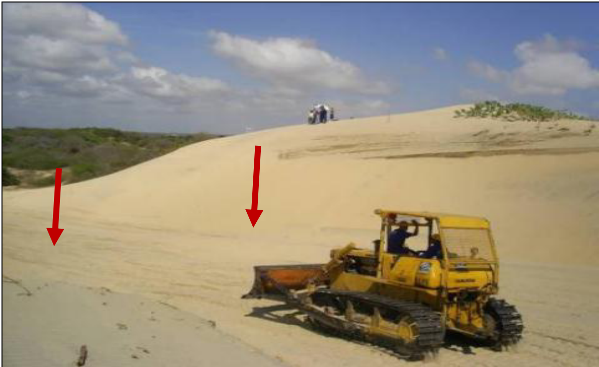
Figura 15 - A duna foi seccionada para a implantação de uma via de acesso no campo de dunas da Taíba, Ceará.
