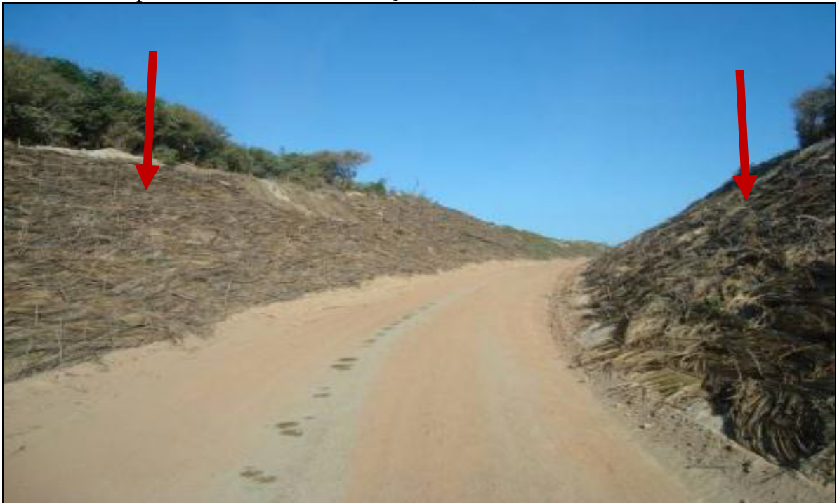
Figura 18 - Utilização de palhas de coqueiro para fixação das areias que se direcionam para a estrada no campo de dunas Cumbe/Canoa Quebrada, Ceará.
