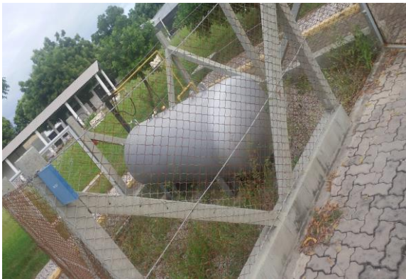
Figura 6 - Sistema de gás liquefeito de petróleo
