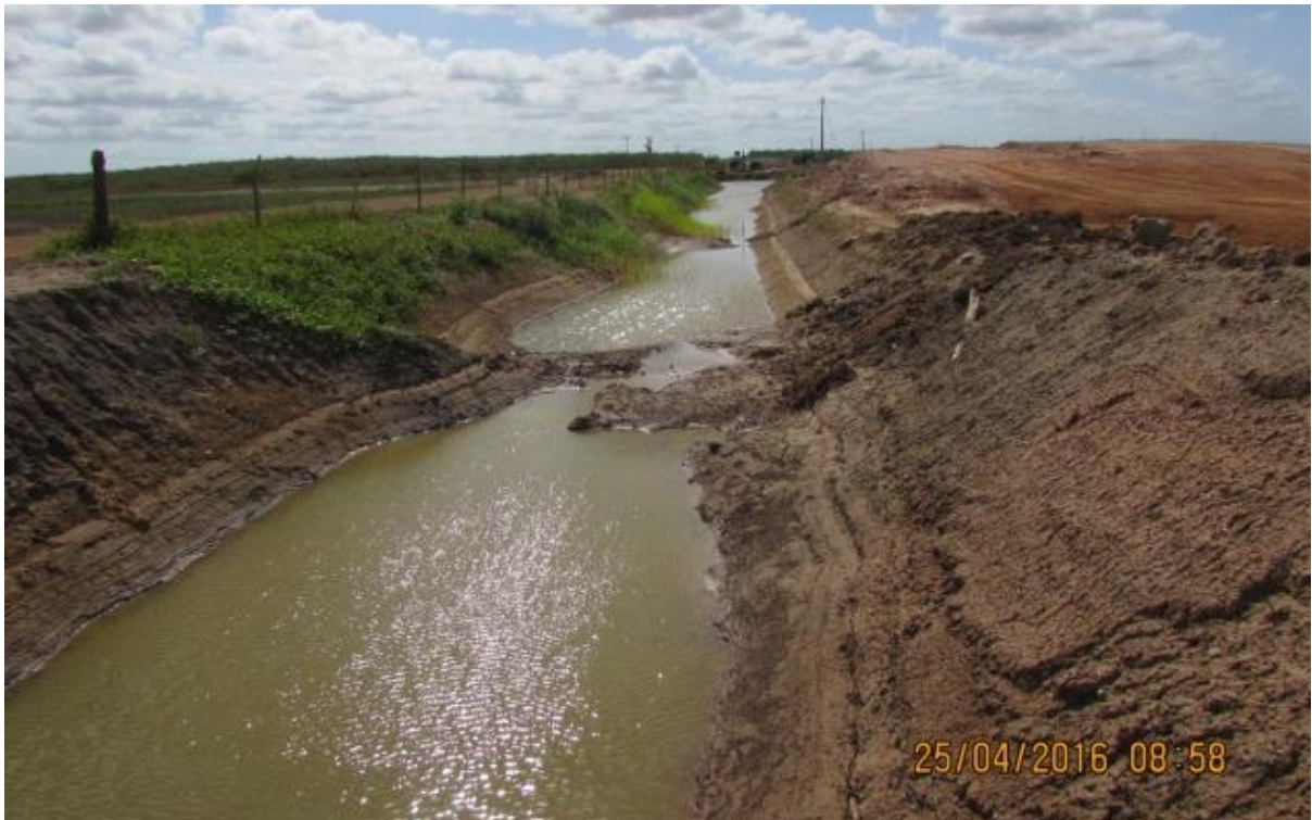
Figura 18 – Canal de transposição para irrigação com pouco volume hídrico
