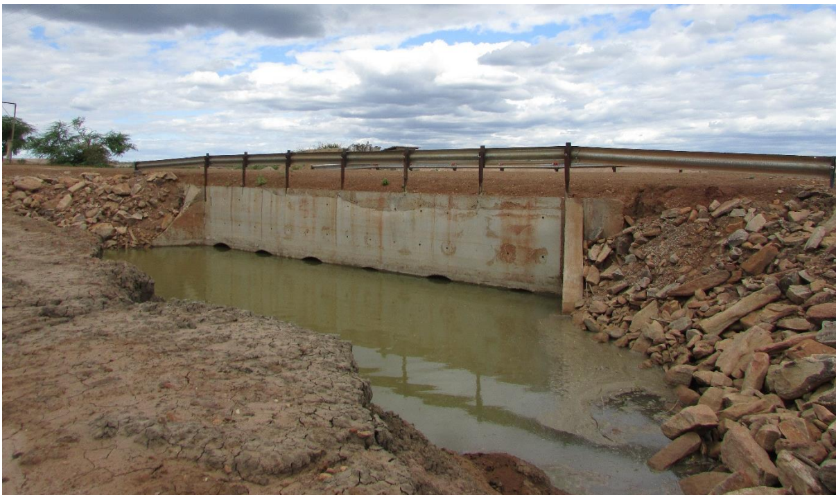
Figura 22 – Dutos de entrada do lado esquerdo do canal de abastecimento que liberam água do lado esquerdo para o direito da lagoa.
