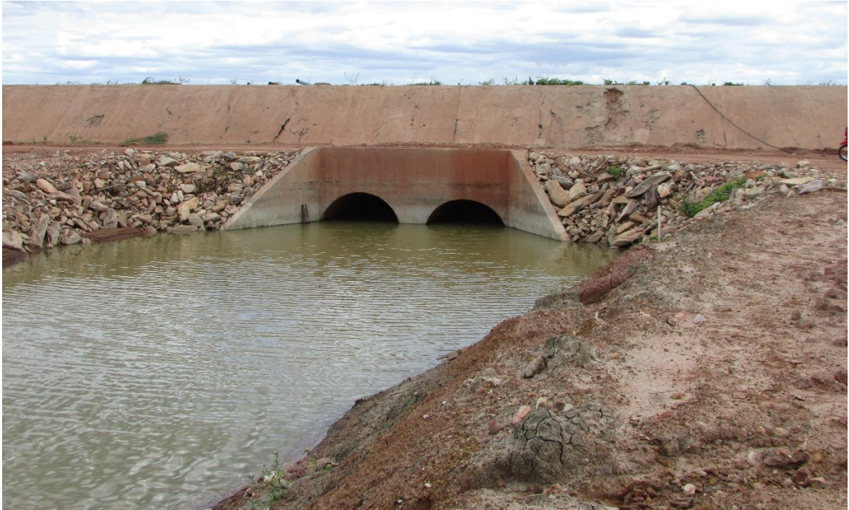
Figura 22 – Dutos de entrada do lado esquerdo do canal de abastecimento que liberam água do lado esquerdo para o direito da lagoa.
