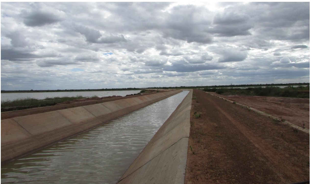
Figura 26 – Canal de abastecimento da empresa Meri Pobo ainda recarregado em julho mesmo com a seca do rio Jaguaribe
