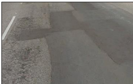
Figura 28 – Detalhe da parte final da medição.
