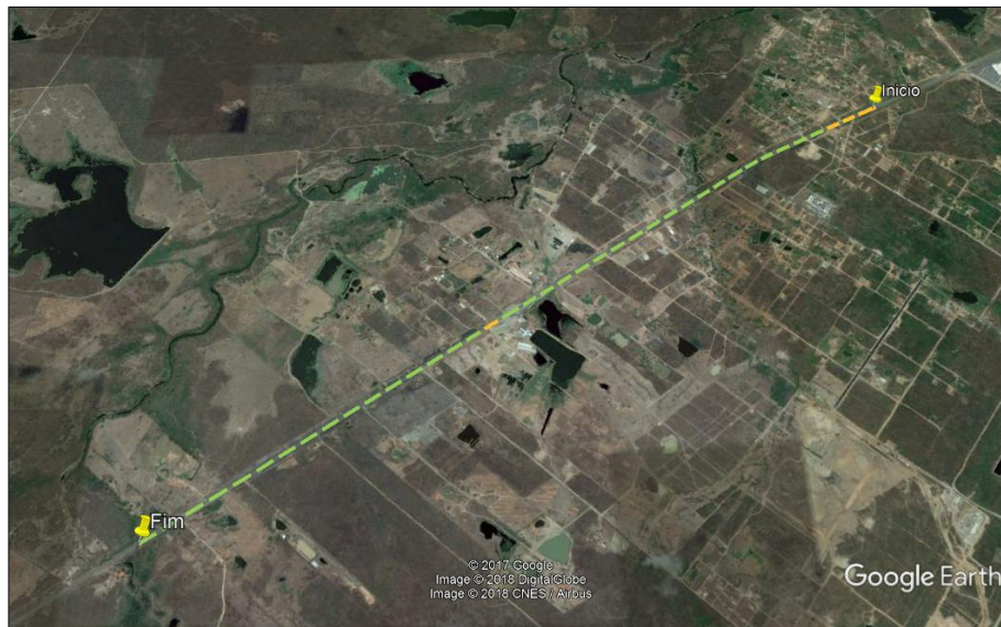
Figura 32 – Trecho BR-020 – Serviço de manutenção
