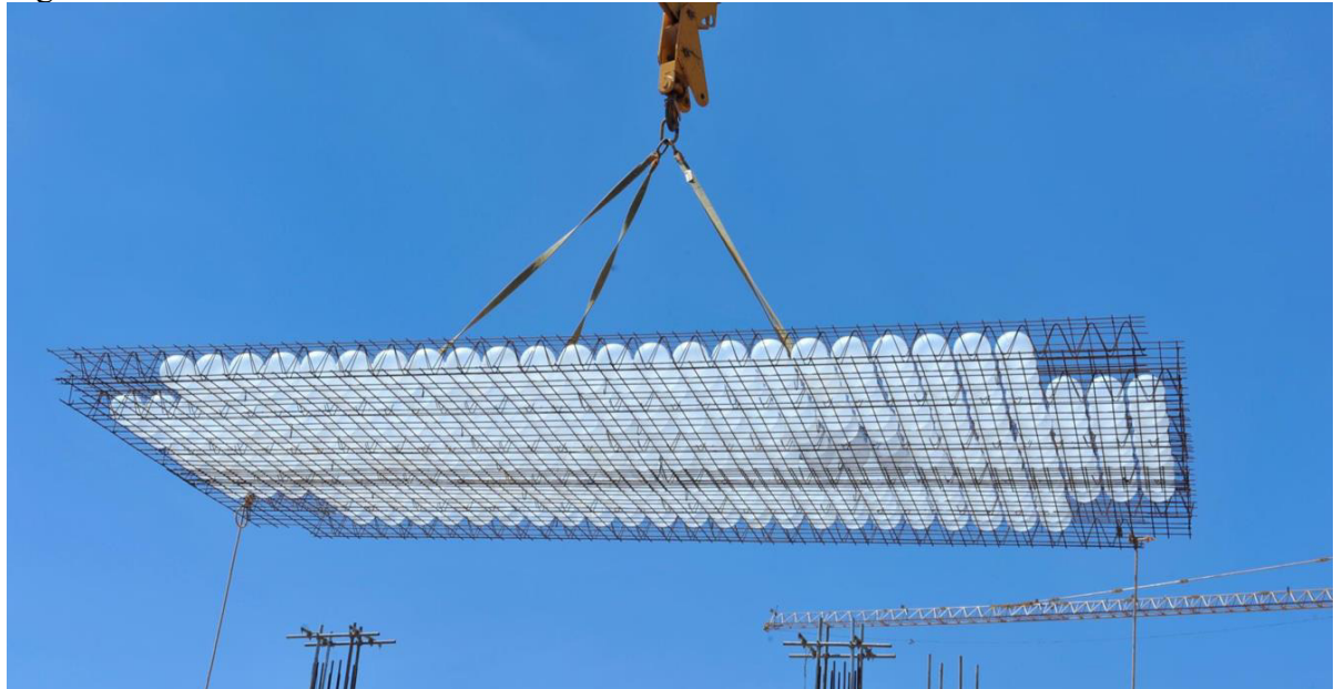
Figura 4 - Sistema de Módulo Bubbledeck
