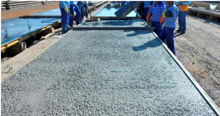
Figura 9 - Lançamento do Concreto
