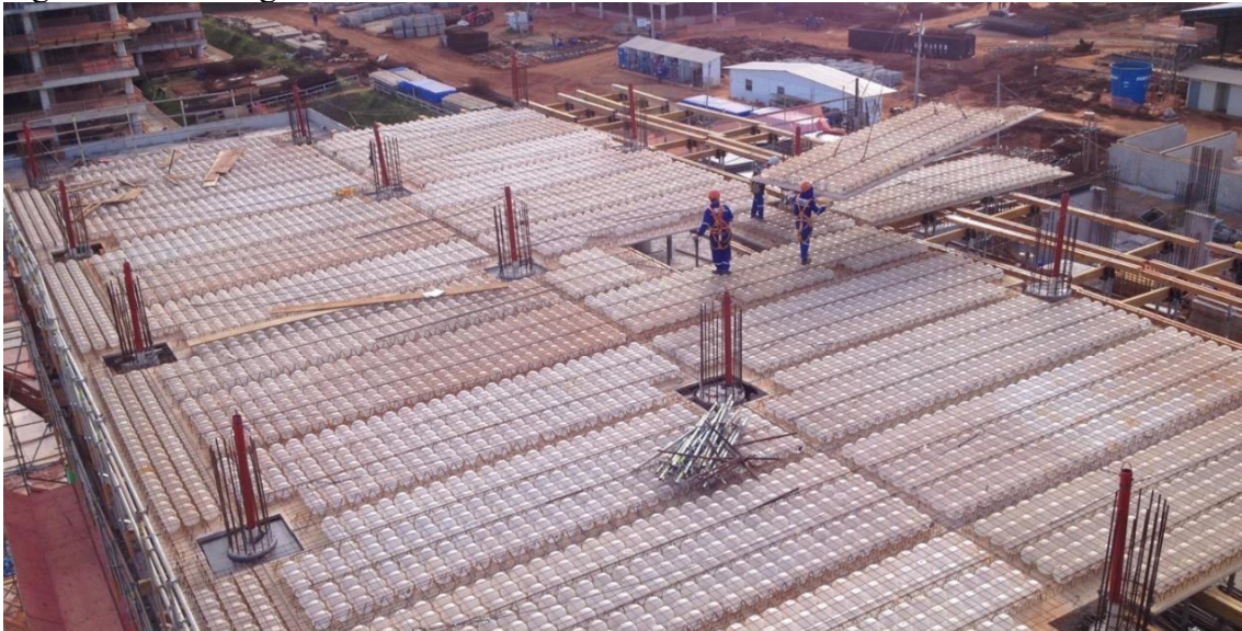
Figura 13 - Montagens do Painéis
