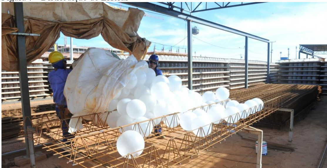
Figura 7 - Distribuição de Esferas
