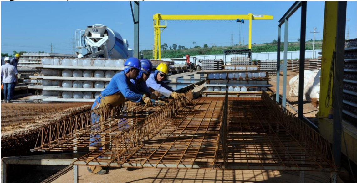
Figura 6 - Armação Inferior e Treliças
