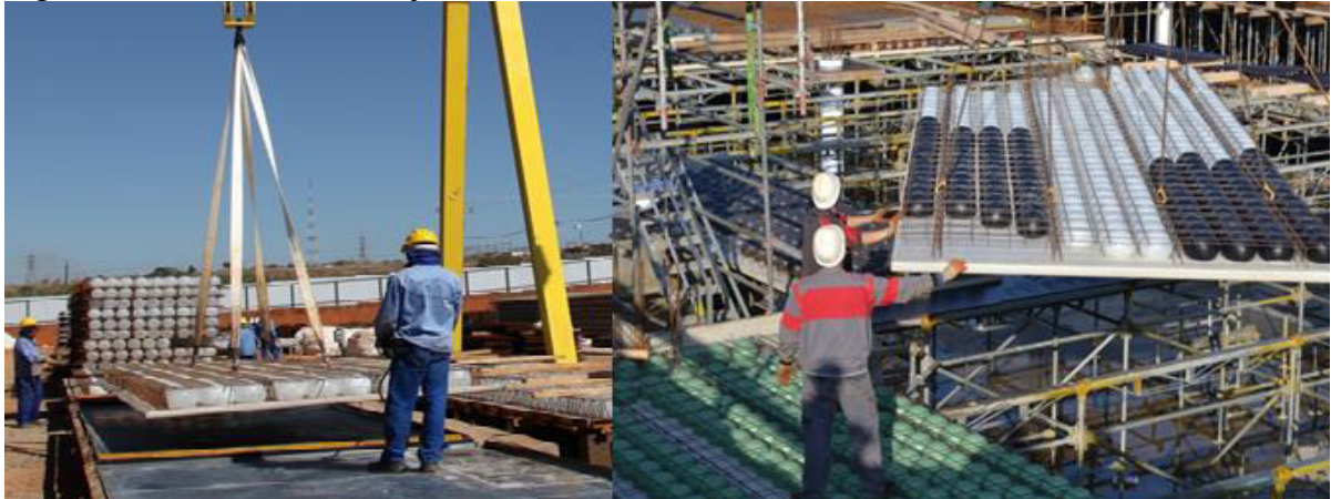
Figura 5 - Sistema de Pré-Lajes Bubbledeck.
