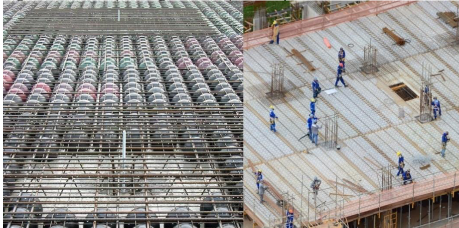
Figura 14 - Armação Negativa/Punção/Colapso
