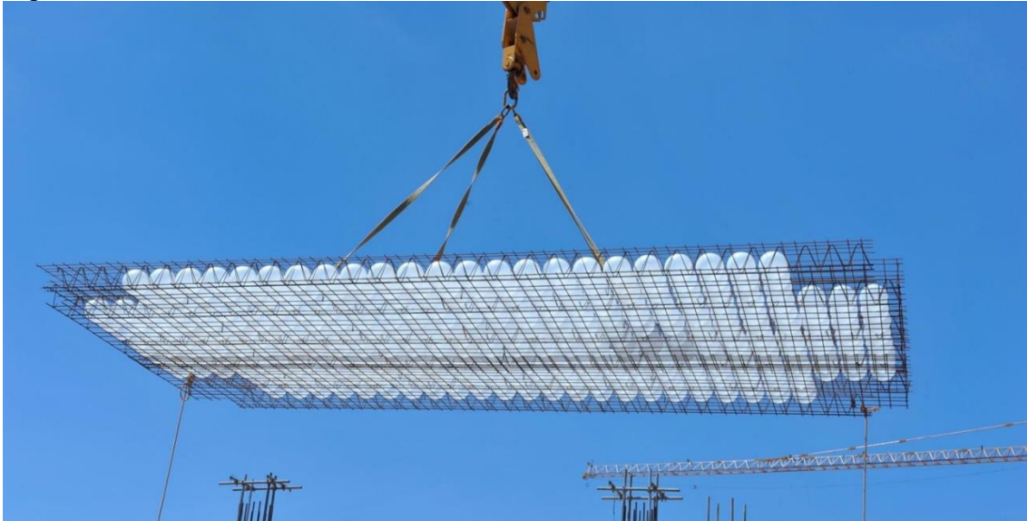
Figura 8 - Modulo Bubbledeck
