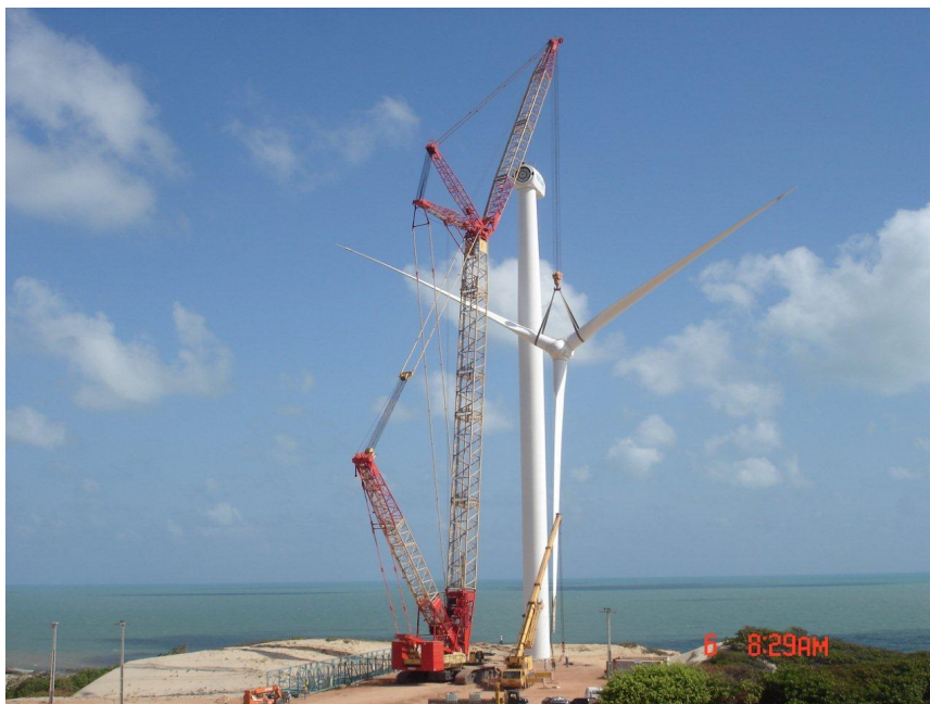
Figura 11 – Gerador eólico de grande porte.
