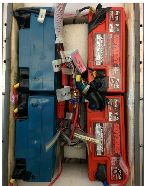
Figura 39 - Identificação dos fios.
