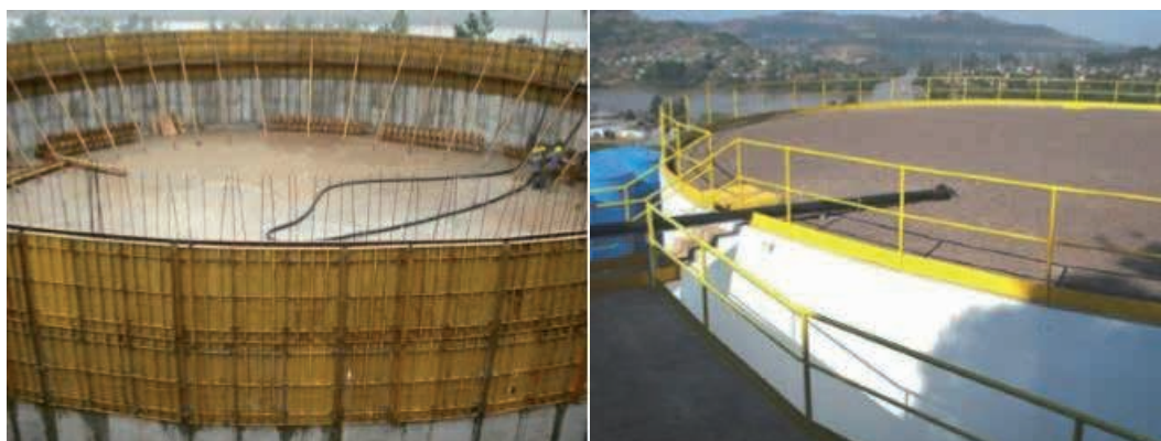
FIGURA 1 - RESERVATÓRIO EM CONCRETO ARMADO (Fonte: Crivelatti, 2010)
