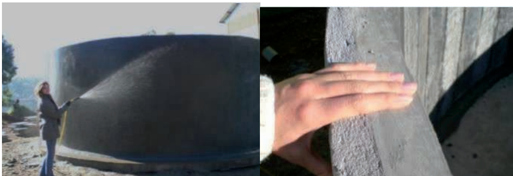
FIGURA 2 - CISTERNA DE FERROCIMENTO (Fonte: Lisboa, 2012)
