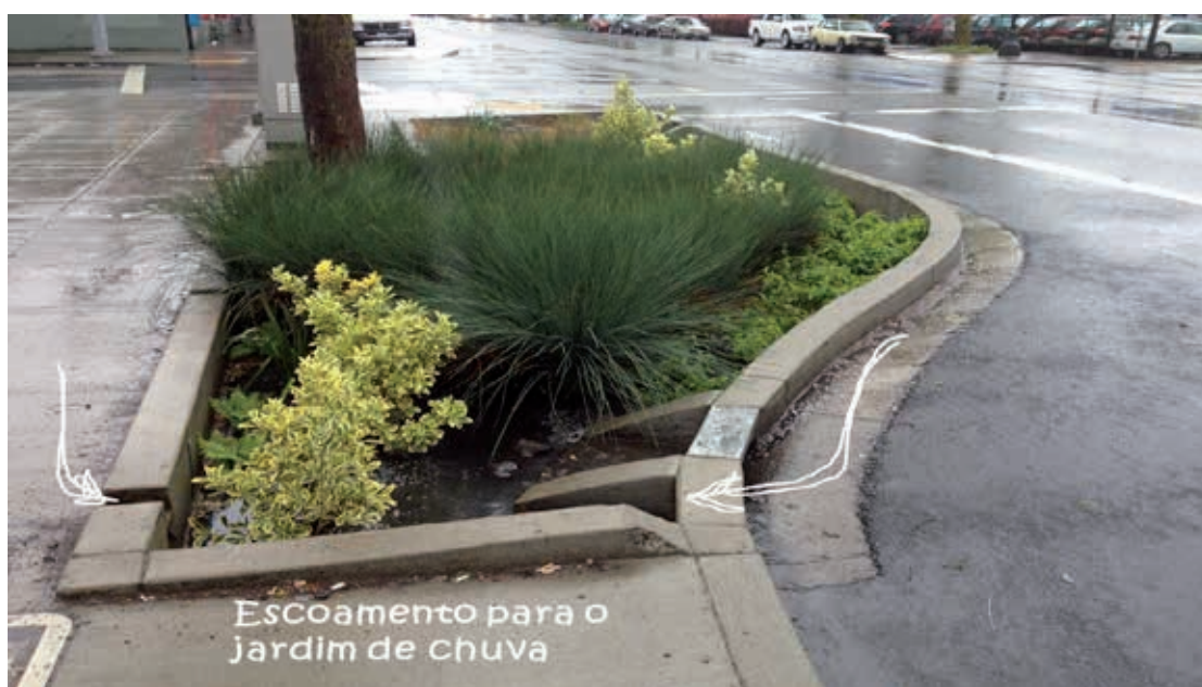
Figura 2 – Escoamento para o jardim de chuva (Fonte: http://thecityfixbrasil.com/2015/04/01/nossa-cidade-os-oito-principios-da-calcada/ )
