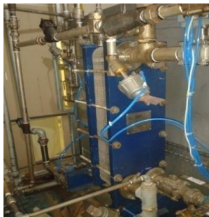
Figura 17 - Sistema de aquecimento e arrefecimento da água para esterilização
