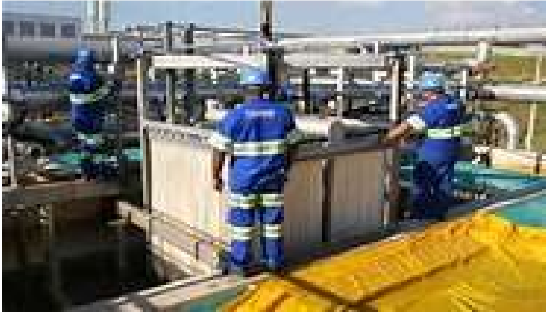
Foto 1 - utilização de água de reuso na indústria
