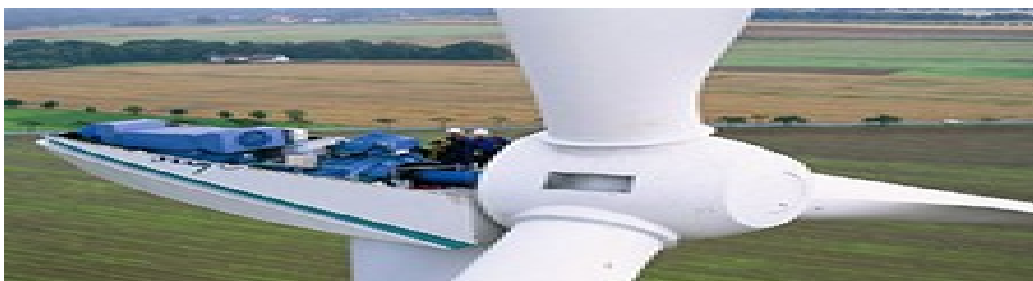
Figura 8 – manutenção e reparo de uma turbina eólica.
