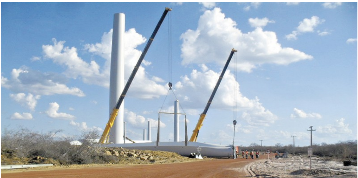
Figura 23 – Construção do parque eólico de Tianguá, Ceará.
