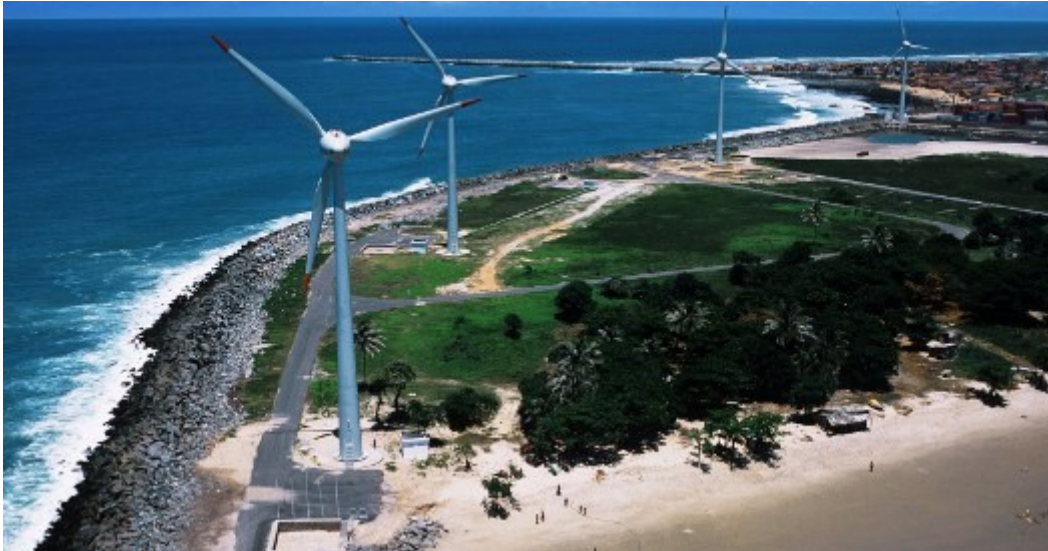
Figura 6 – Usina Eólica do Mucuripe, Ceará.
