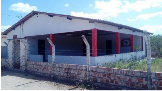
Figura 10 - Casa-sede do Assentamento.
