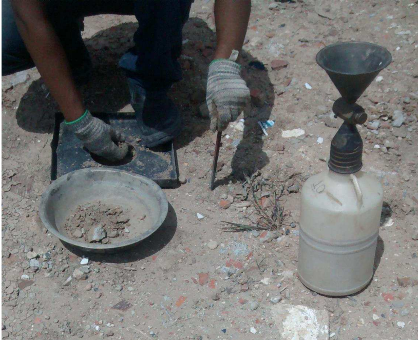
Figura 10 – Escavação do furo para determinação do peso específico “in situ” pelo método de frasco de areia.
