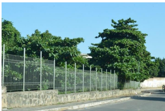
Figura 10 – Cerca de proteção do Parque São Bartolomeu, 21/04/2015
