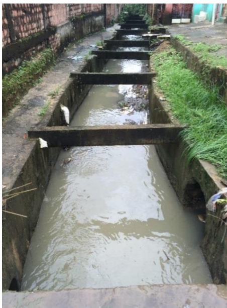
Figura 11 – Corpo hídrico canalizado, 08/07/2015
