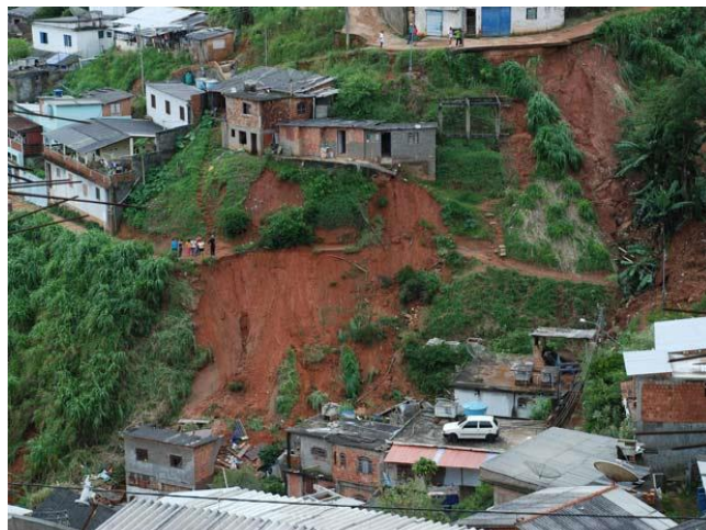
Figura 1 - Deslizamento de terra em Teresópolis, RJ
