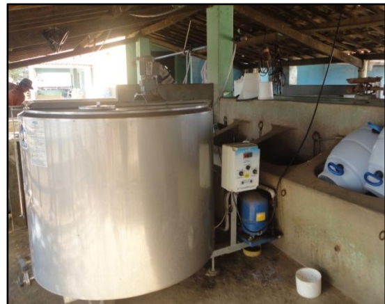
Figura 57 – Tanque próprio na sala de ordenha
