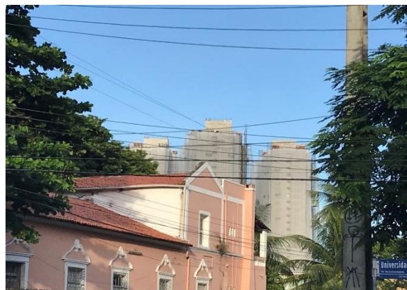
Figura 25 – Prédios em construção vistos da Av, da Universidade
