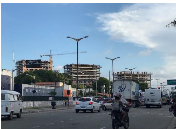
Figura 24 – Prédios em construção vistos da Av. Carapinima
