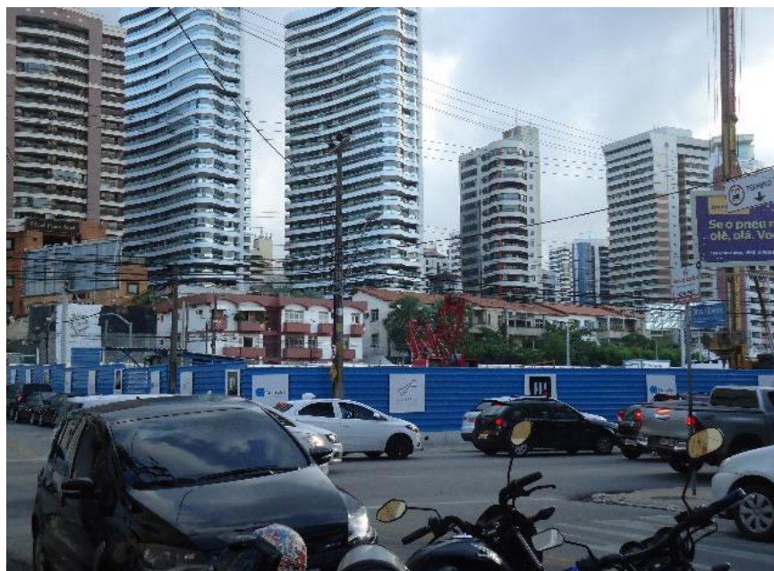
Figura 7 – Outra torre por vir
