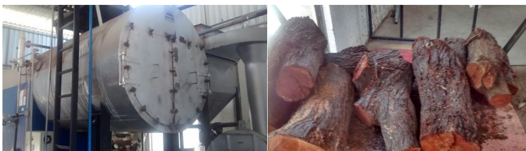
Figura 11. Sistema de caldeira a base de casca e madeira.
